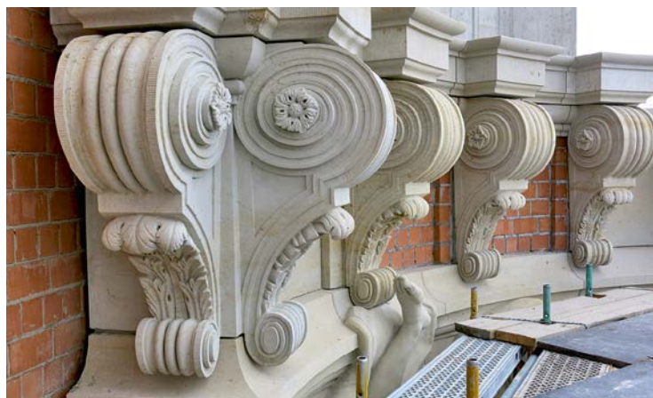
Die großen Konsolen des Hauptgesimses von Portal III entstanden wieder in alter Schönheit.
