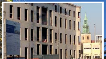
Bauzustand Mitte April 2015
