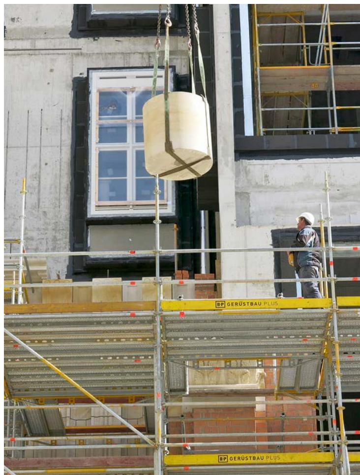
Schlüterhof: Einbau einer Trommel der Kolossalsäulen vor Portal VI
