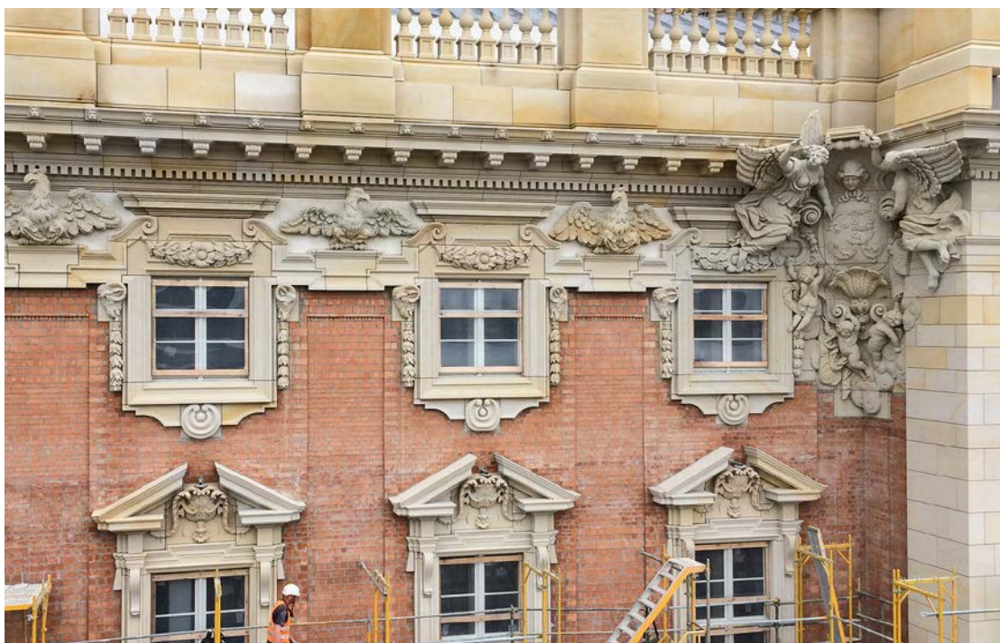
Die Schönheit der Schlossfassaden wird sichtbar. Sie werden erst am Ende der Bauzeit ca. 2017/18 verputzt und sehen dann so aus wie oben in der inzwischen abgebrochenen Musterfassade.
