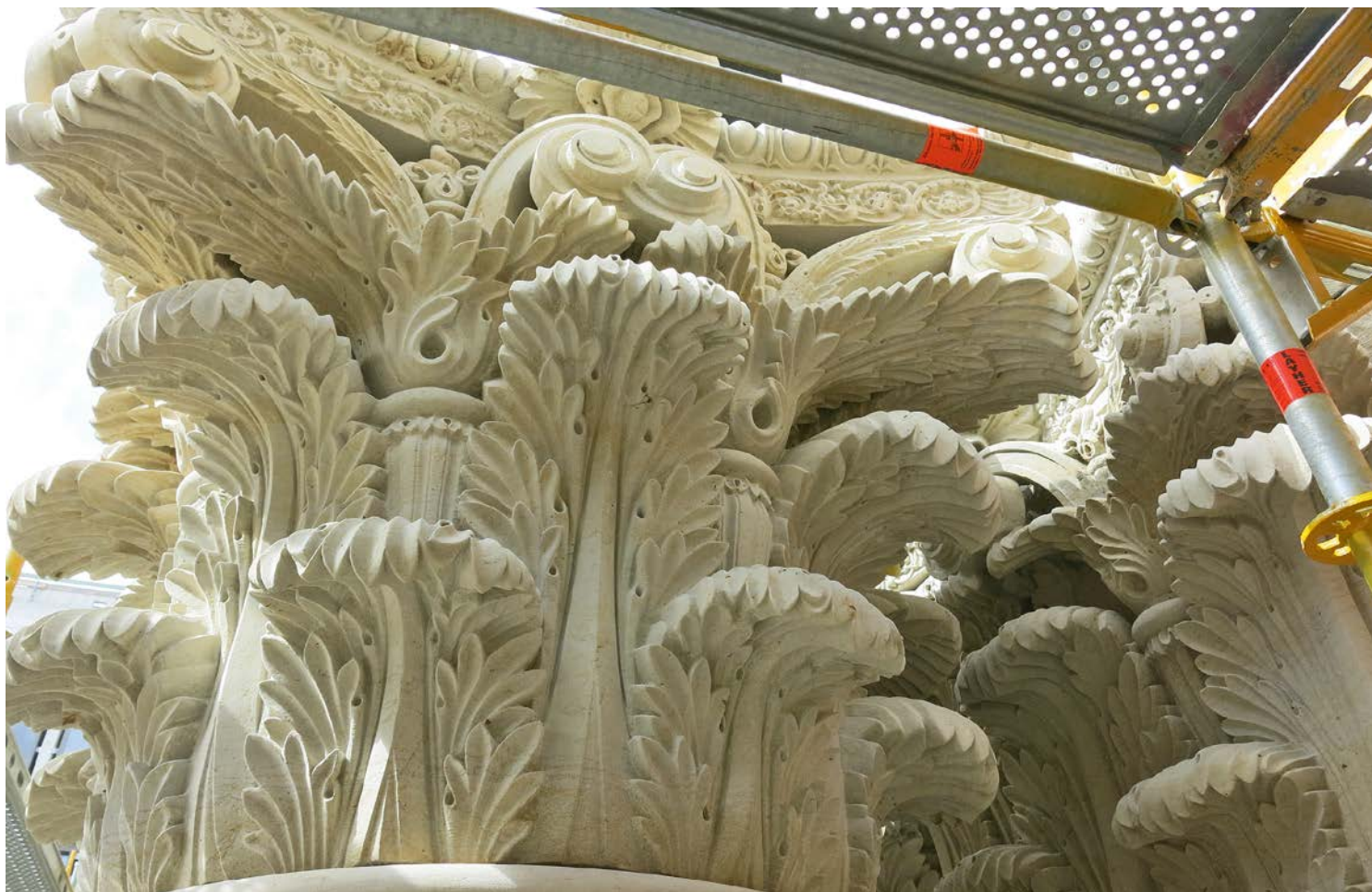
Prachtvolle Arbeit: Die originalgetreu rekonstruierten Kapitelle der Kolossalsäulen und – Pilaster im Schlüterhof wurden eingebaut. (s. auch Seite 57)
