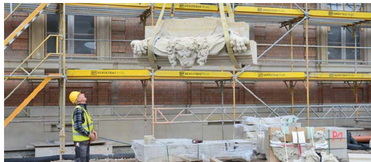
Einbau der Reiterkartusche in Portal I. Der Herkulesmantel, ein Löwenfell, schwebt an seinen Standort.
