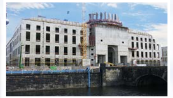
Bauzustand Mitte April 2015
