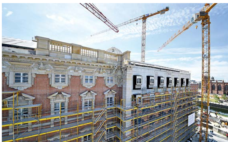
So schön kann alles werden: Ein wenig Schloss mal ohne Gerüst!
