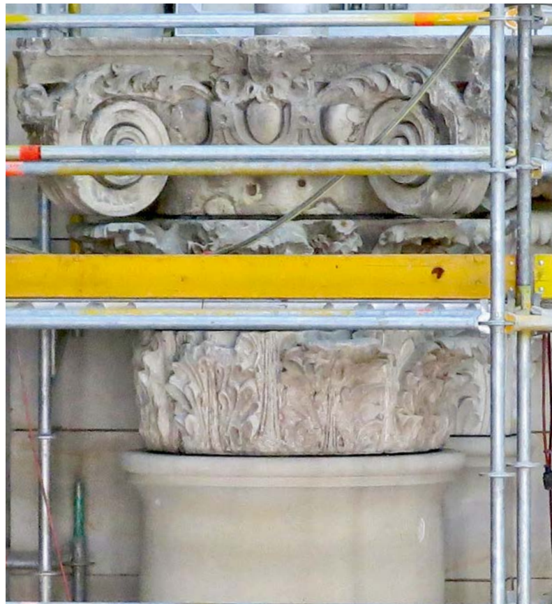
Im Foyer wurde das einzige vollständige Kapitell von Portal III gereinigt wieder eingebaut.
