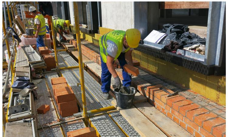
Die Wand wird im Mauerwerk mehr als 60 cm stark, über alles sogar bis zu 1,10 m
