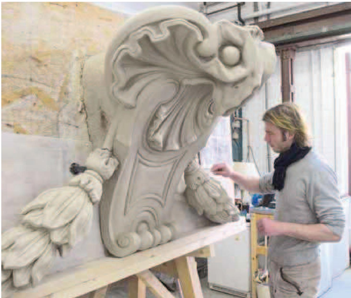
Bildhauer Eckhart Böhm modelliert aus Ton ein Bukranion, den Schmuck der Fensterverdachung des 1. Stockwerks des Schlüterbaus
