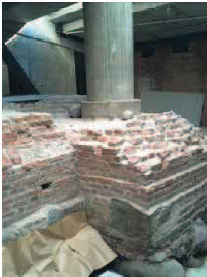
Schlossburg Vilnius, Litauen. Auch hier wurde das neue Schloss über den historischen Fundamenten errichtet. Um die Tragfähigkeit zu sichern, wurden die Grundmauern mit Betonpfählen durchbohrt und der Neubau auf diese gestellt. Vorbild für Berlin.
