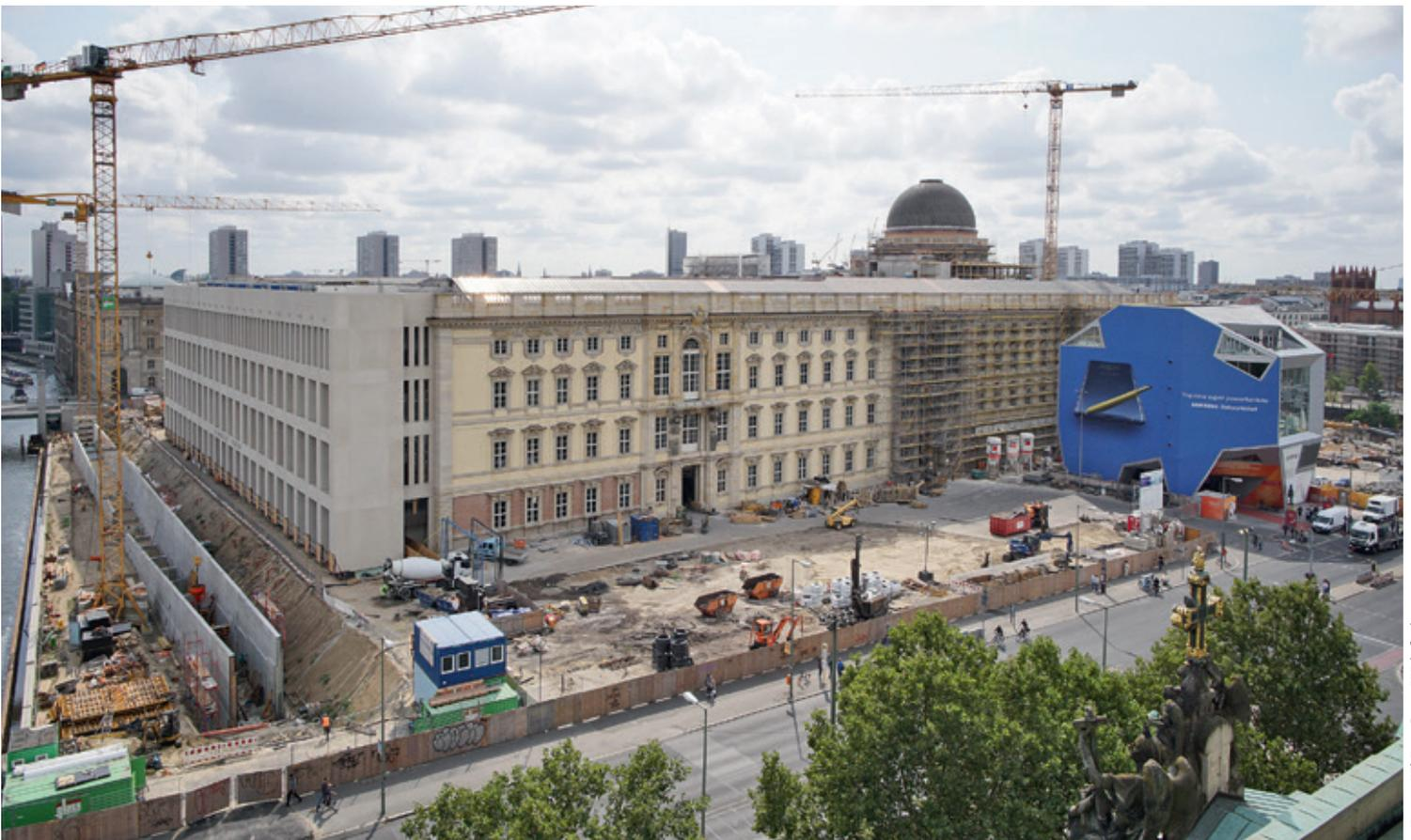
Die Lustgartenfassade mit dem bis auf Restarbeiten fertigen Portal V. Dieses wird noch im Bereich der Hermen Frühling und Sommer weiter überarbeitet. Links sieht man den Bau der Stützmauern der Spreiterrassen.
