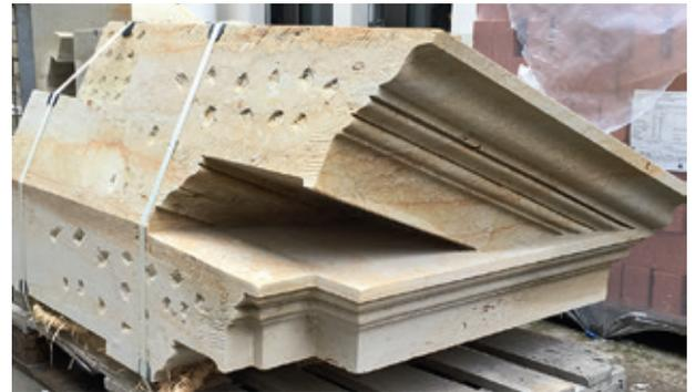
Selbst die nach dem Einbau zierlich wirkende Fensterverdachung besteht aus einem tonnenschweren Sandsteinblock!
