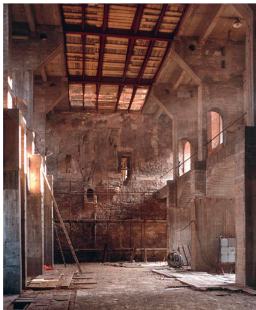
Die Schlosskapelle im Rohbau. Sie bestand 1945 nach dem Bombardement nur noch aus den Außenmauern. Wände und Gewölbe waren völlig zerstört. Heute hat sie wieder ihr kostbares Schlingrippengewölbe zurückerhalten. Ein solches befand sich auch in der Erasmuskapelle des Berliner Schlosses.
