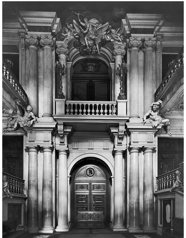
Gesamtansicht der Rückwand des Gigantentreppehauses
