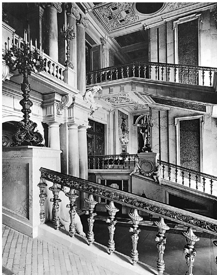
Die Rampe, auf der man nach oben auch reiten konnte!
