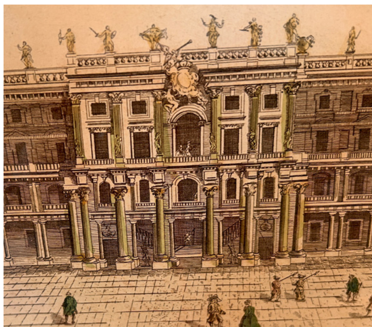
Die Portalrisalite im Schlüterhof waren ursprünglich nicht verglast. Dadurch entstand eine Einheit der Außenarchitektur mit der Inneren im Treppenhaus. Auf diesem Guckkastenbild von 1740 schauen Menschen aus den offenen Fassadenöffnungen. Ebenso sieht man die Stufen der Wendeltreppe unten.
