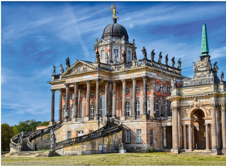
Commun des Neuen Palais in Potsdam nach der Sanierung (Universität Potsdam)
