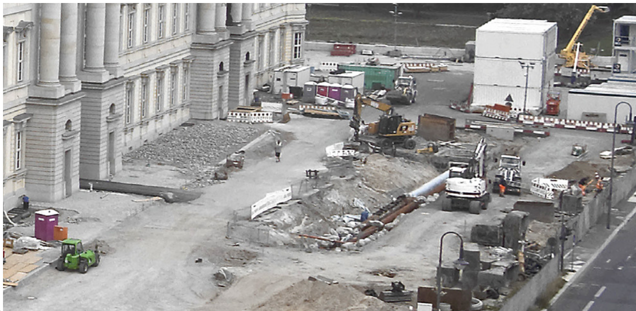
So sah die alte Fernwärmeleitung nach ihrer Freilegung aus.
