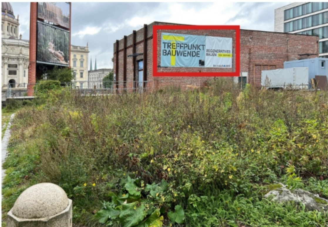
Berlin: Verunkrauteter, völlig lieblos behandelter Bauplatz von Schinkels Bauakademie gegenüber dem Schloss und dem Auswärtigen Amt. Ist das etwa die Bauwende?
