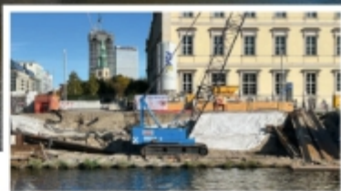
Die Baustelle Ende Oktober 2025
