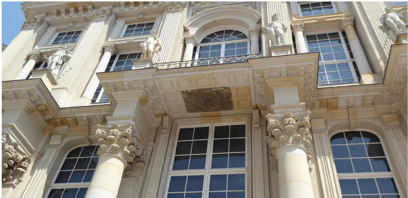
Abb. 3 Das Mittelteil des Gigantentreppenrisalits im aktuellen Zustand; das Balkonplattenfragment ist an seiner dunkleren Färbung gut erkennbar, 2024.
