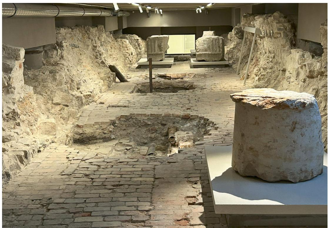
Der Keller unter dem Kuppelportal III. Die Sprengkrater und die zerfetzten Wände des ursprünglich tunnelgewölbten Ganges zeigen die brutale Wucht der Sprengung dieses Portals.
