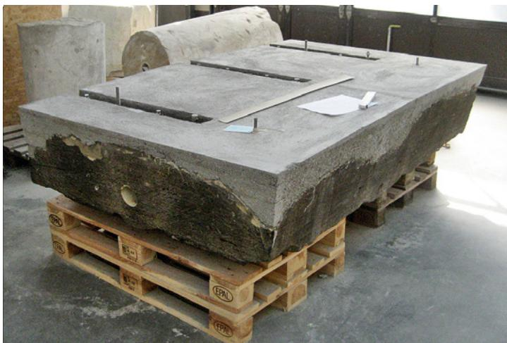
Abb. 6 Bauseits restauriertes Balkonfragment vom Gigantentreppenrisalit, aufgeständert in Einbaulage; der Aufbeton und eine der Durchbohrungen für die neuen Anker ist zu erkennen; Schloßbauhütte Berlin-Spandau, 2016.
