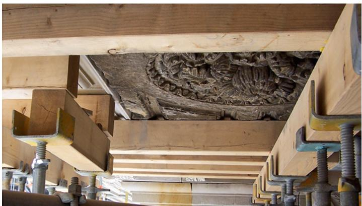
Abb. 8 Balkonfragment in Einbauzusammenhang am wiedererrichteten Gigantentreppenrisalit, Untersicht, noch mit Abstützungen, 2017.
