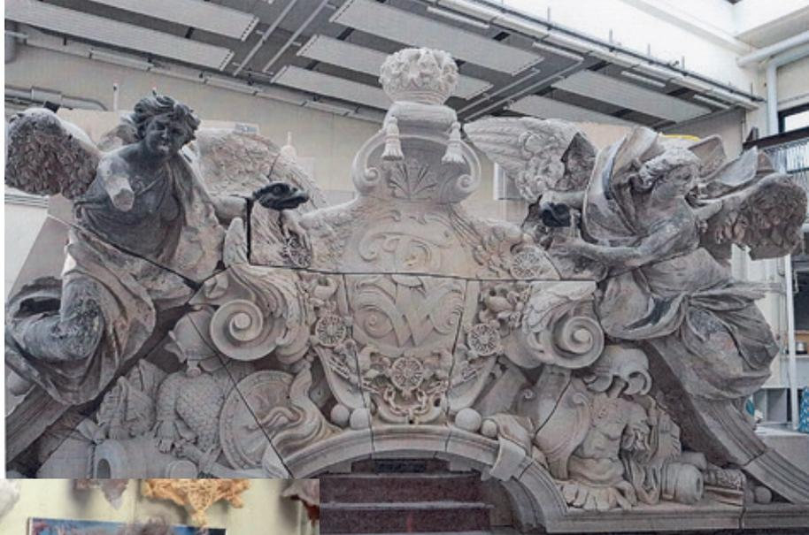
2018. Die fertig vormontierte Bekrönung in der Schlossbauhütte. Dies war nötig, um notwendige Anpassungen der Steine vorzunehmen. Beim Einbau in 20 Metern Höhe am Schloss wäre das ein kompliziertes Unterfangen geworden!
