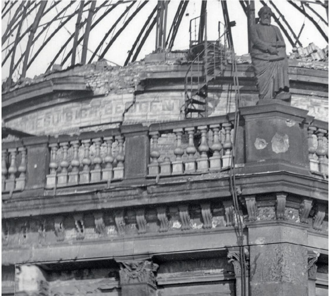
Die ausgebrannte Schlosskuppel vor der Sprengung 1950. Deutlich sieht man die zerstörten Hohlkörper der Terrakotten an den Konsolen des Gesimses und die weggeplatzten Pilasterkapitelle.
