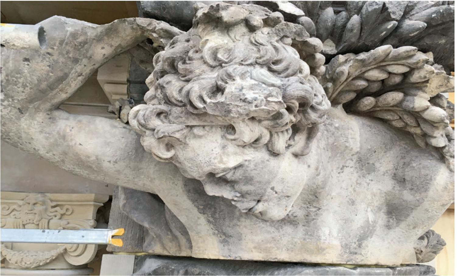
Original des Hermenpilasters Sommer, Balthasar Permoser zugeschrieben. Die Farbunterschiede zwischen dem Kopf- und dem Brustteil rühren daher, dass das Brustteil eine Rekonstruktion des verwitterten Originals aus dem späten 19. Jh. ist und man damals wohl nicht auf die Identität der verwendeten Sandsteine achtete. Wir haben für Sie den „Sommer“ auf der Architekturzeichnung links rot umrahmt!
