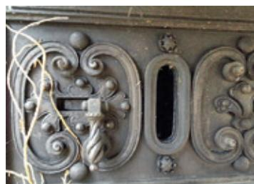
Der Riegel mit geöffneter Schießscharte
