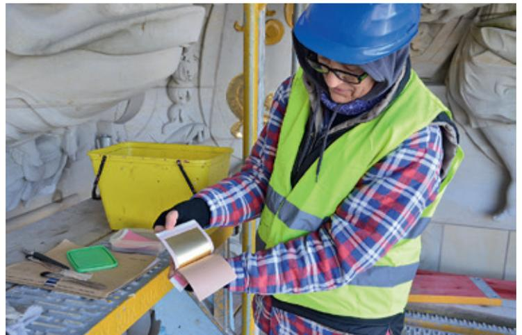
Hauchdünn gehämmertes, reines Blattgold wird bei der Vergoldung der Details verwendet.
