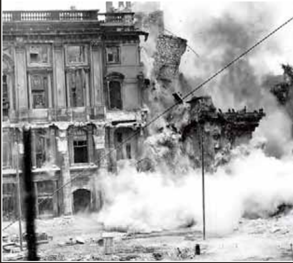
Sprengung des Schloßhofs.
