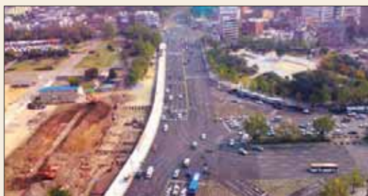
Vorbereitung für die erneute, originalgetreue Rekonstruktion des Haupttors
