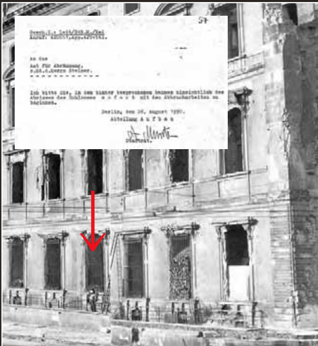
Beginn der Vernichtung: Arbeiter bohren Sprenglöcher in die Südwestseite der Schlossmauern, Anfang September 1950
