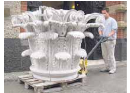
Oben und unten: Der Gipsabguss als Vorlage für den Steinbildhauer
