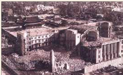
Abbruch des Gouverneurspalastes 1995
