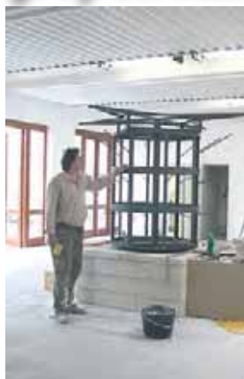
Die Unterkonstruktion des Kapitells
