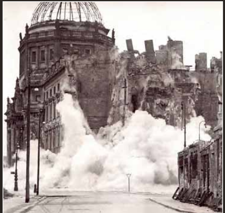
Die Sprengung der Südwestecke am 7. September 1950
