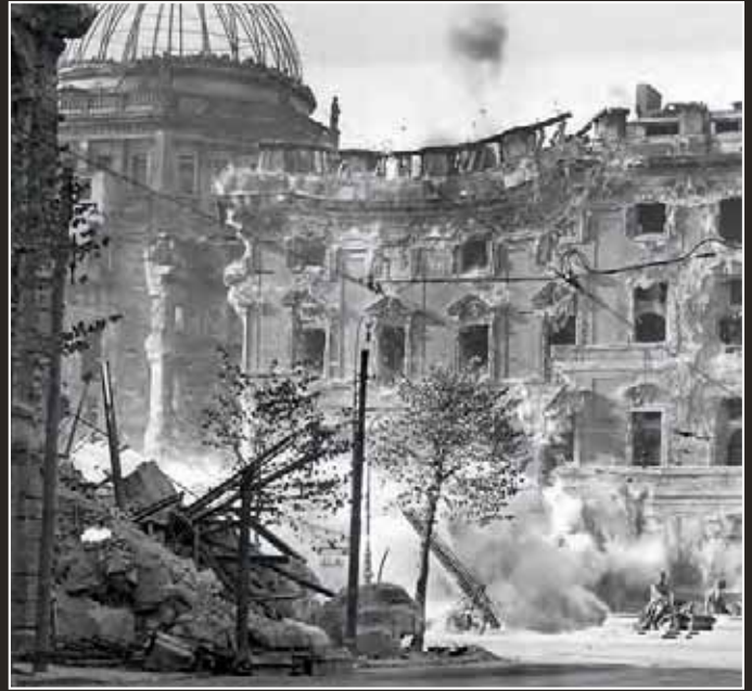
Sprengung eines Teils der Schlossplatzfassade. Der Schornstein bläst durch den Sprengdruck ein letztes Mal ein Rußwölkchen aus
