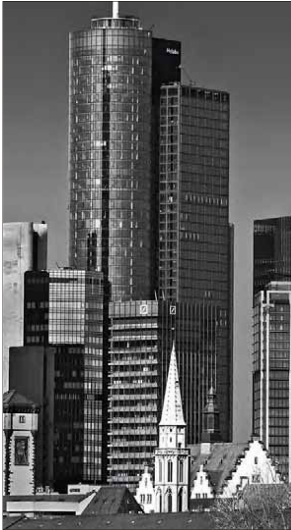
Frankfurt am Main, Alte Nikolaikirche vor Maintower
