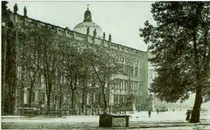
Schloss Lustgartenfassade vom Dam aus gesehen, 1921
