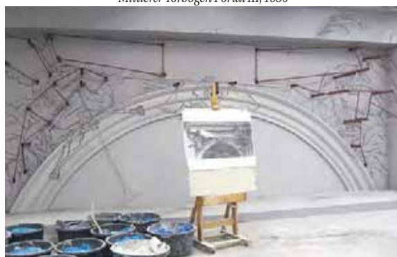
Mittlerer Torbogen Portal III, Unterkonstruktion 2009
