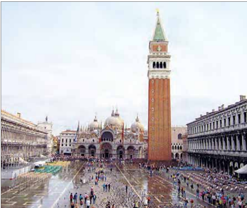
Die Aussichtsplattform des historischen Campanile in Venedig konnte nur über eine enge Treppe erreicht werden. 1906 wollte man deswegen einen Fahrstuhl nach oben einbauen. Dabei störte die reichliche Eisenarmierung. Sie wurde beseitigt. Der Turm verlor seine Stabilität und stürzte ein. Übrig blieb nur ein Steinhaufen. Heute bewundert man eine originalgetreue Kopie!
