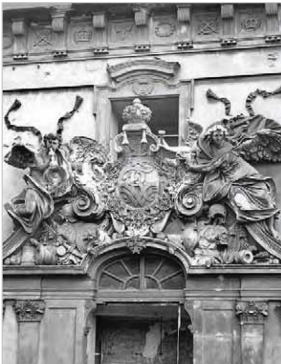
Supraporte Innenportal Großer Schlosshof. Hier haben wir inzwischen viele weitere Originalteile identifiziert, die für die geplante Rekonstruktion im Schlossforum (s. Seite 2) verwendet werden können.
