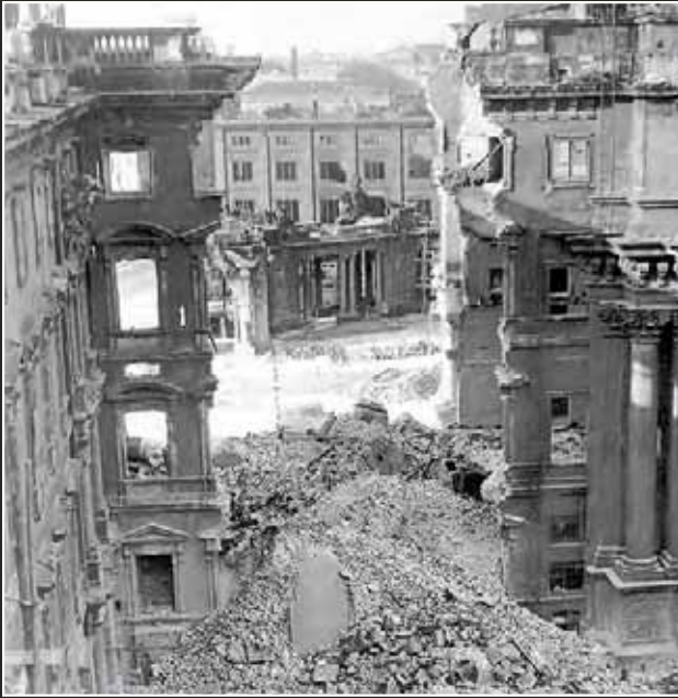
Wirkung der Sprengung der Südwestecke auf die unversehrten Fassaden im Großen Schlossohof
