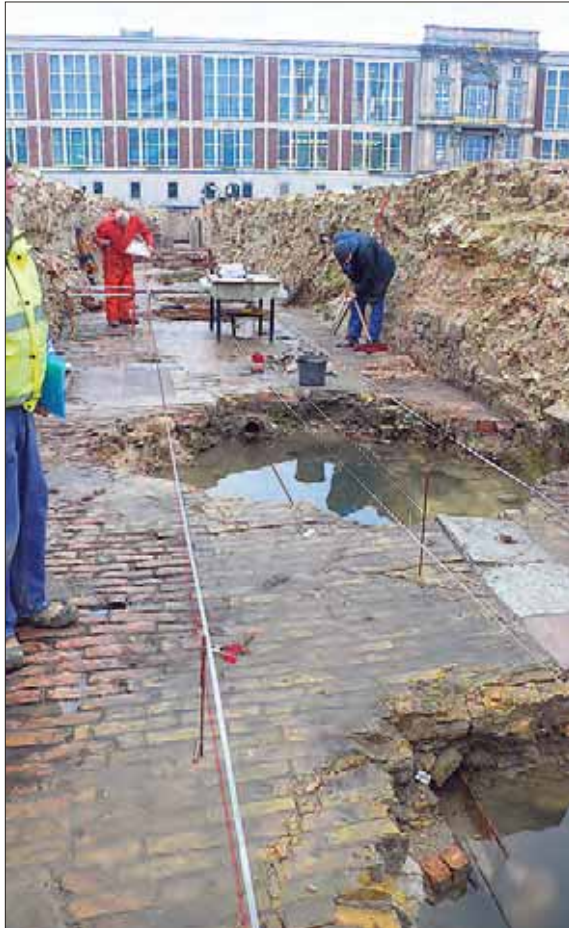
Hier war einmal ein niedriger Gang unter dem Eosanderportal mit einem massiven Tonnengewölbe. Hunderte Kilo Dynamit zerfetzten bei der Sprengung des Portals diesen Gang, hoben das gewaltige Portal um etwa 30 cm in Luft, das bei dem Aufprall zusammenstürzte. Zurück blieben die hier zu sehenden Sprengkrater im Boden des Gangs und seine zerfetzten Seitenwände.
