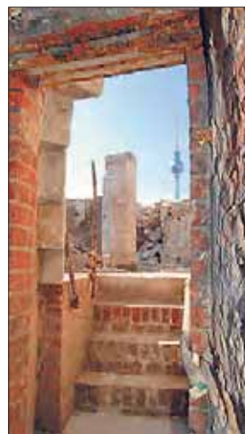
Hier war einmal ein niedriger Gang unter dem Eosanderportal mit einem massiven Tonnengewölbe. Hunderte Kilo Dynamit zerfetzten bei der Sprengung des Portals diesen Gang, hoben das gewaltige Portal um etwa 30 cm in Luft, das bei dem Aufprall zusammenstürzte. Zurück blieben die hier zu sehenden Sprengkrater im Boden des Gangs und seine zerfetzten Seitenwände.
