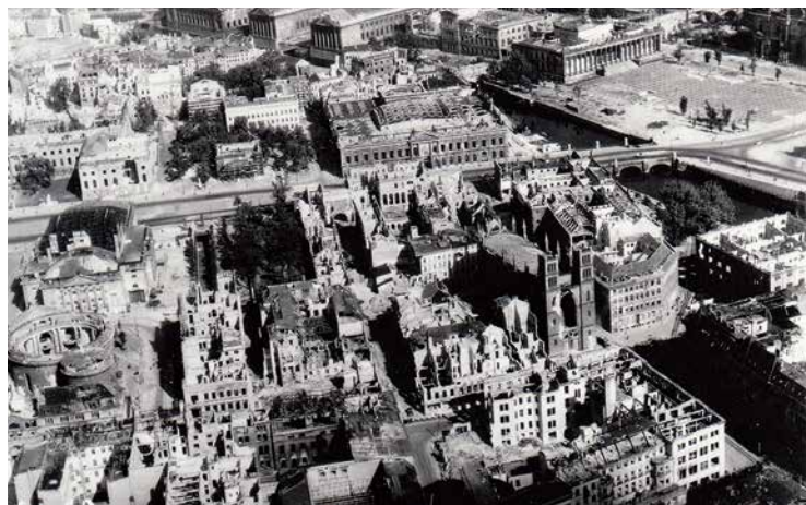
Die zerstörte Mitte am Schinkelplatz, direkt an dem Spreekanal.
