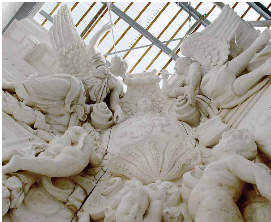
Ansicht von unten. Die Fugen markieren den künftigen Schnitt der Sandsteine. Links Mitte, wenn es bleiben sollte: Bozetto der Kartusche im Maßstab 1:3
