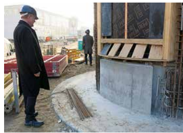
Eckronde II, Fundament für die historische Fassade
