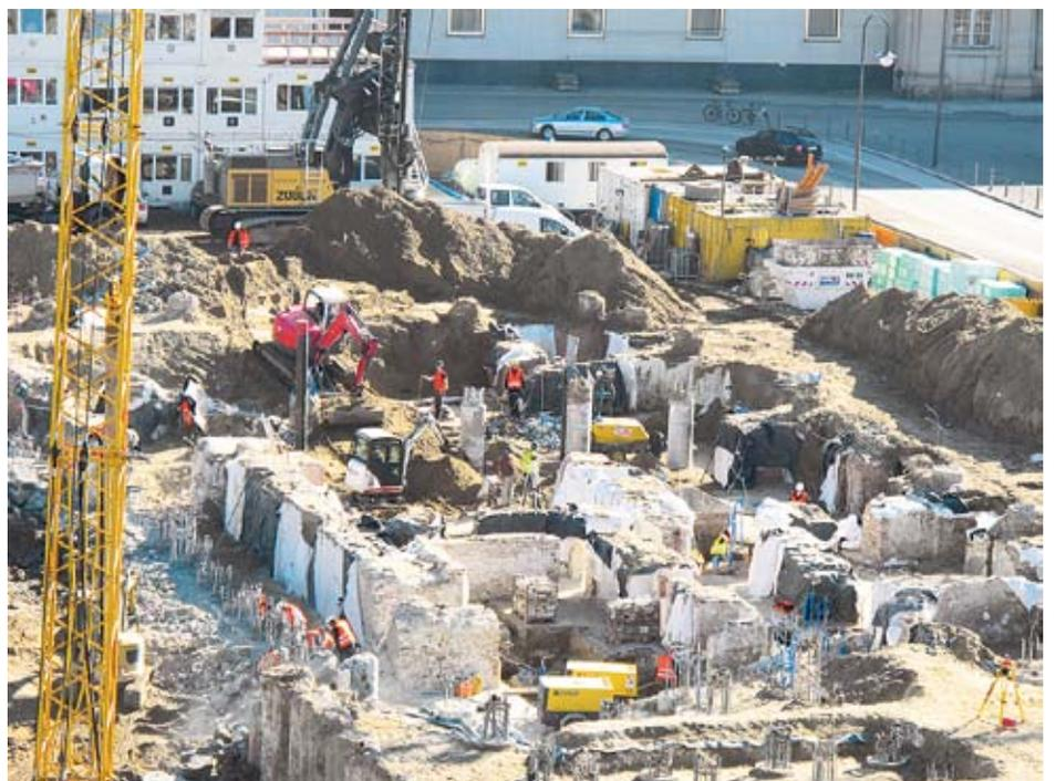
Die historischen Keller wurden zunächst wieder zugeschüttet, um mit schwerem Gerät vierzig Meter lange Bohrpfähle als neues Fundament des Schlosses einzubringen. Die alten Fundamente sind nicht mehr belastbar und "schwimmen" im neuen Schlosskeller. Sie werden begehrbar sein und museal genutzt werden. Rechtes Bild: Die Keller werden wieder freigelegt.
