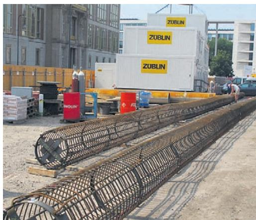
40 m lange Stahlarmierungen für die Bohrpfehle.
