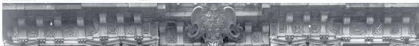
Das Hauptgesims des Schlüterhofs im Bereich von Portal V
