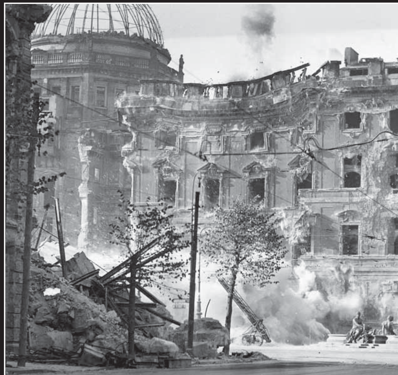
Sprengung eines Teils der Schlossplatzfassade. Der Schornstein bläst durch den Sprengdruck ein letztes Mal ein Rußwölkchen aus
