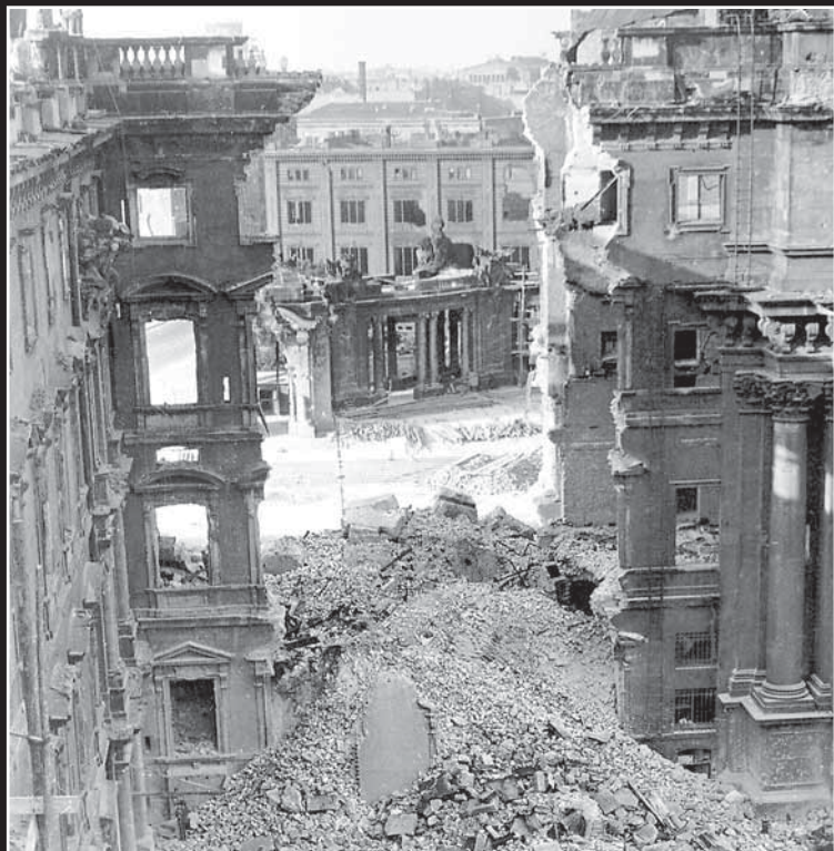
Wirkung der Sprengung der Südwestecke auf die unversehrten Fassaden im Großen Schlosshof
