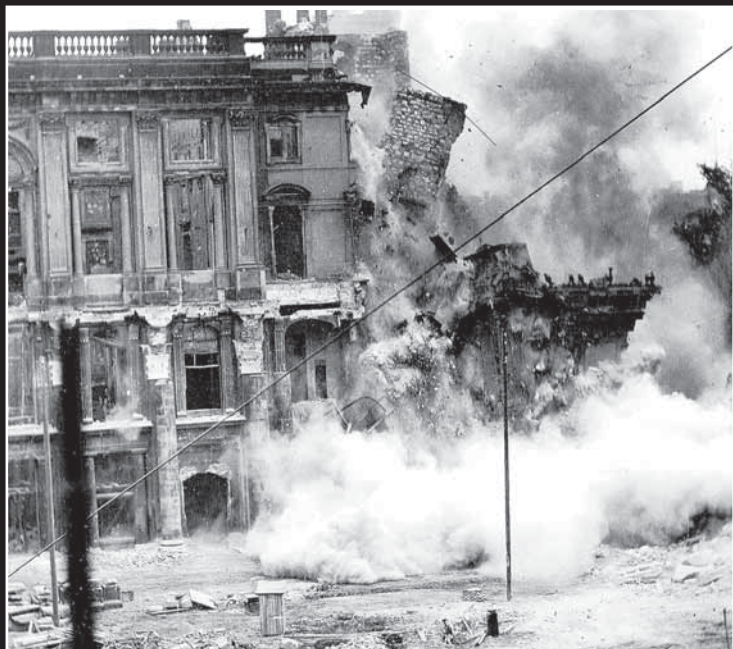
Sprengung des Schloßhofs
