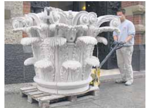
Oben und unten: Der Gipsabguss als Vorlage für den Steinbildhauer
