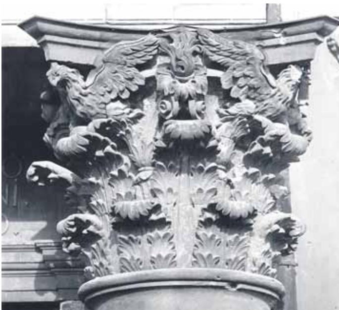
Der fertige Prototyp des korinthischen Kapitells der großen Säulenordnung von Portal I und II, 2010
