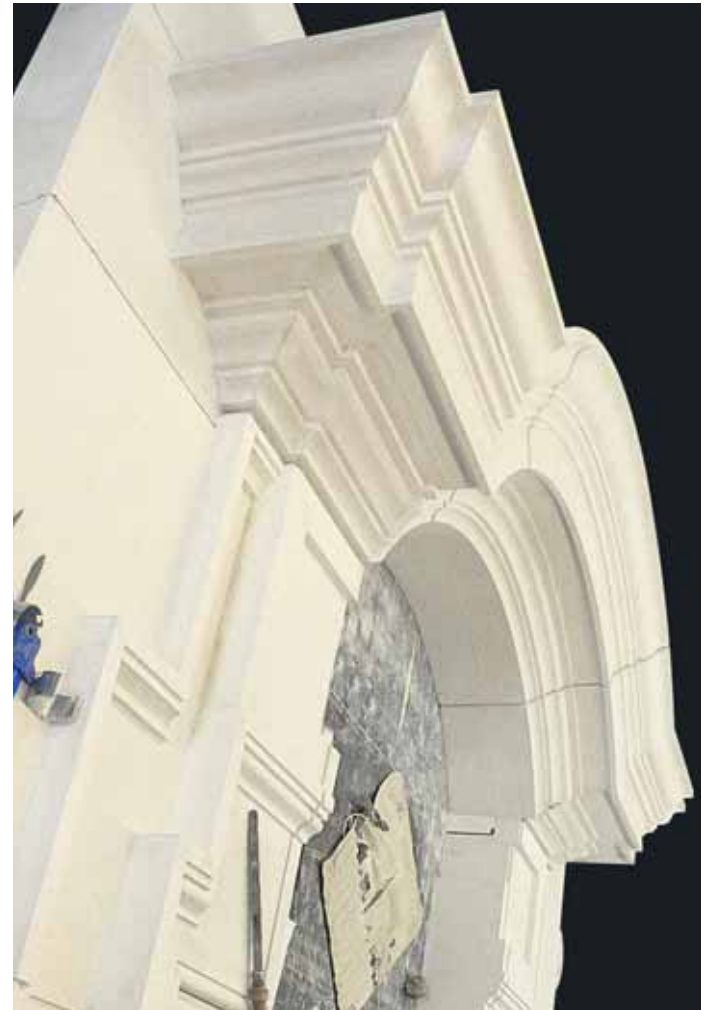
Auch die Fensterverdachung des 1. Stockwerks steht als Modell für die Sandsteinausfertigung zur Verfügung
