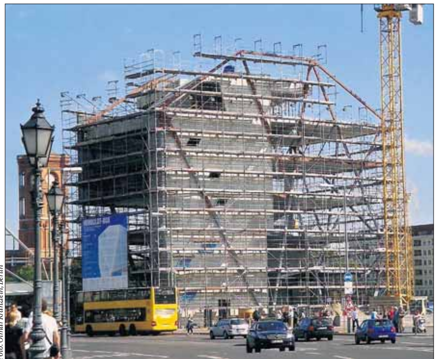
Rohbau hinter Gerüsten im August 2010
