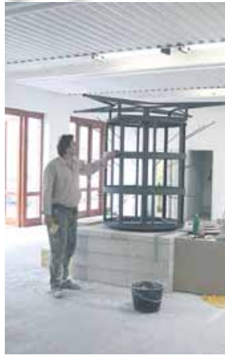
Die Unterkonstruktion des Kapitells
