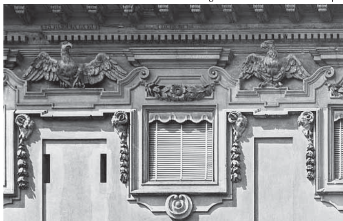
Die Adler überbrückten mit ihren Flügeln den Abstand zwischen den Mezzaninfenstern. Die Unregelmäßigkeit dieser Abstände ergab so auch unterschiedliche Spannweiten
