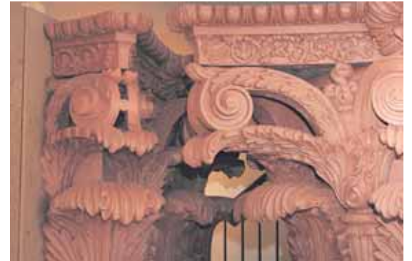
1:1 Modelle aus Plastilin, Kolossalkapitelle der Säule und des Pilasters
