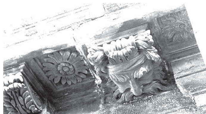
Wildermann-Konsole: Original und Rekonstruktion in Ton
