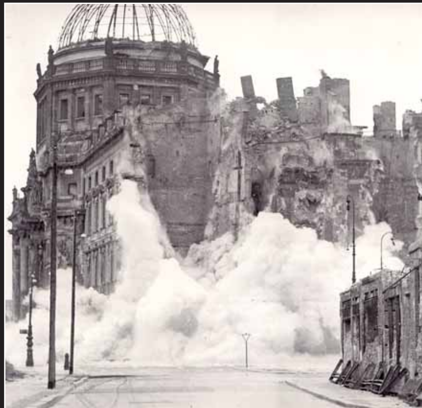
Die Sprengung der Südwestecke am 7. September 1950
