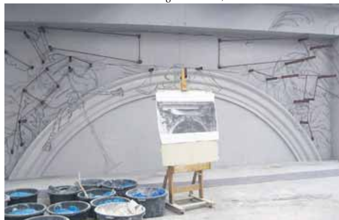
Mittlerer Torbogen Portal III, Unterkonstruktion 2009
