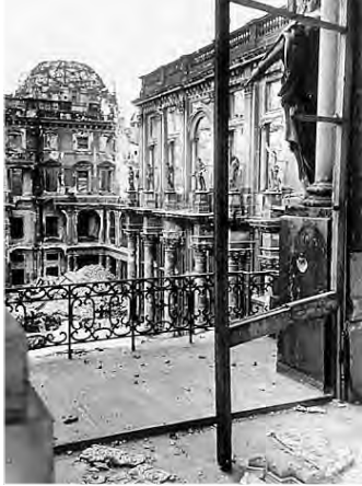
Kurz vor der Sprengung im Herbst 1950: Blick aus dem Vestibül des Elisabethsaals in den Schlüterhof. Über der Nordfassade sieht man die ausgebrannte Kuppel des Berliner Doms.
