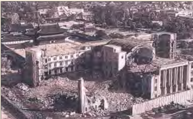
Abbruch des Gouverneurspalastes 1995
