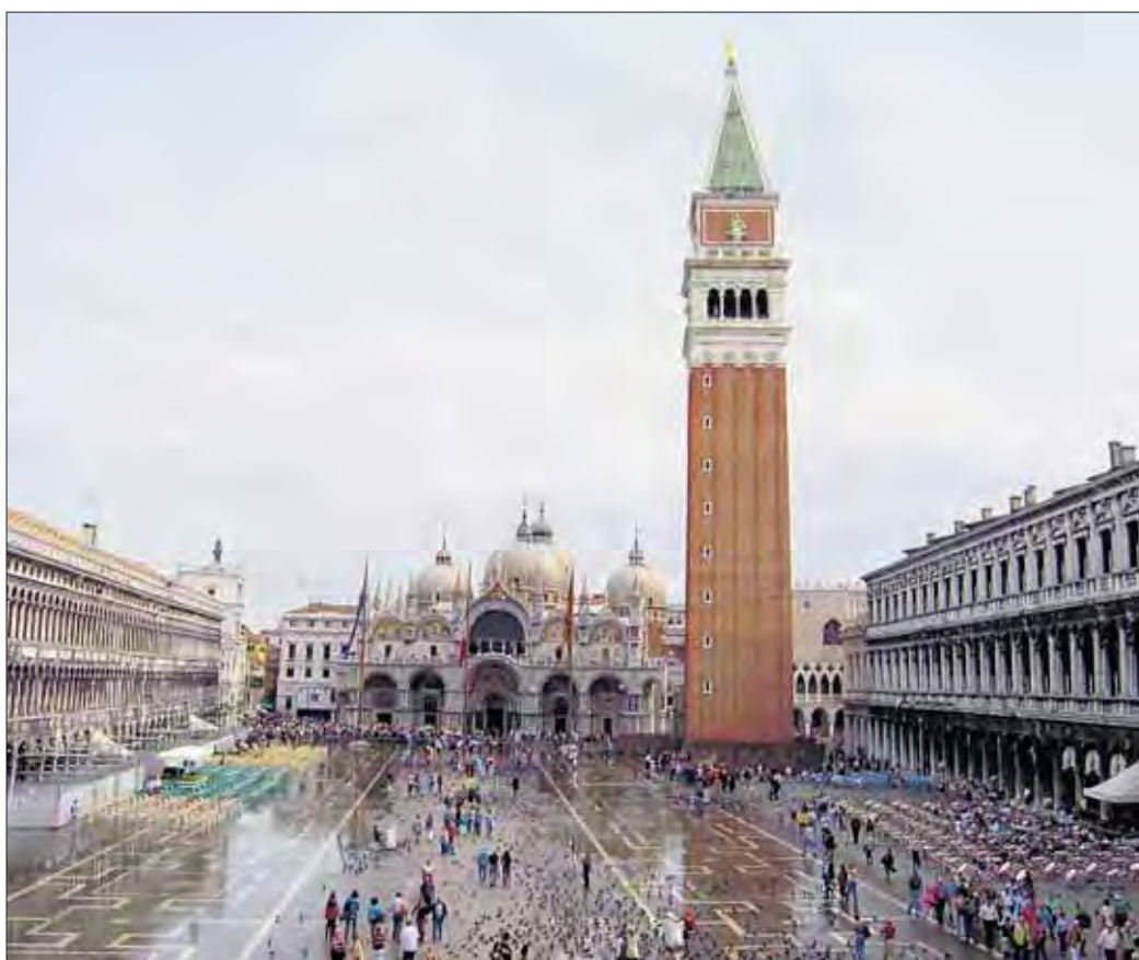
Die Aussichtsplattform des historischen Campanile in Venedig konnte nur über eine enge Treppe erreicht werden. 1906 wollte man deswegen einen Fahrstuhl nach oben einbauen. Dabei stürzte die reichliche Eisenarmierung. Sie wurde beseitigt. Der Turm verlor seine Stabilität und stürzte ein. Übrig blieb nur ein Steinhaufen. Heute bewundert man eine originalgetreue Kopie!
