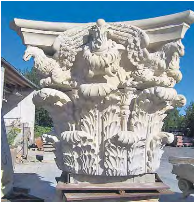
Kolossalkapitell Portal I und II. Fertiger Prototyp in Sandstein geschlagen
