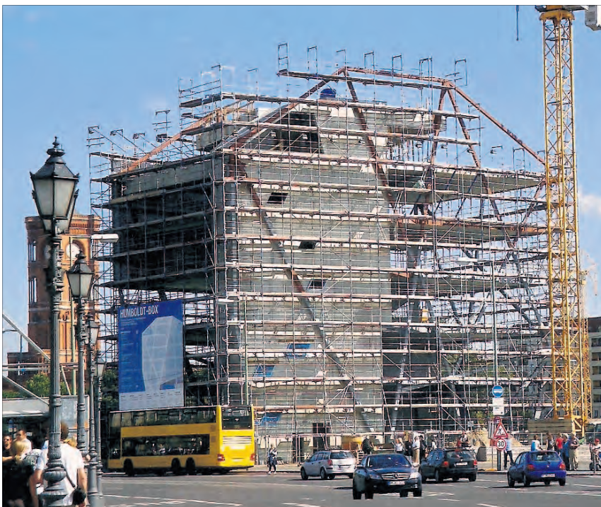
Rohbau hinter Gerüsten im August 2010
