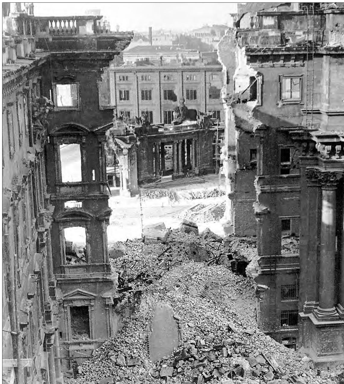
Die Südwestseite des Schlosses ist niedergelegt. Erste große Sprengbresche im großen Schlossohof.
