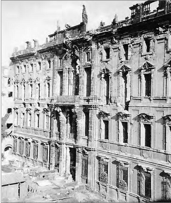
September 1950. Lustgartenfassade mit Portal V, 1950, erste Vorbereitungen zur Sprengung.
