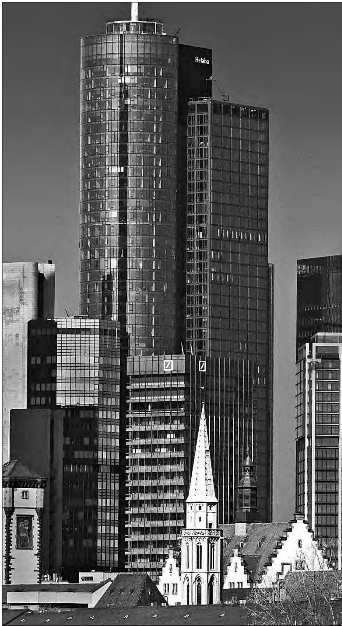
Frankfurt am Main, Alte Nikolaikirche vor Maintower
