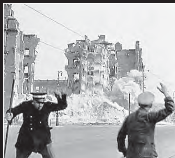
Sprengung eines Teils der Südfassade. Die Straßenkehrer zucken beim Sprengknall erschreckt zusammen.
