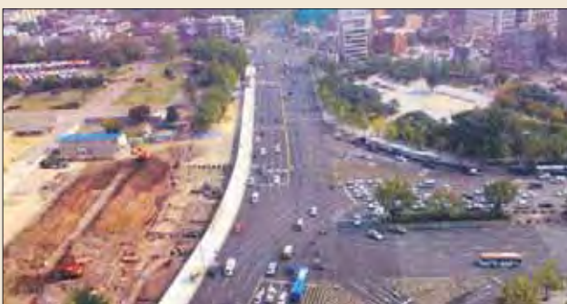
Vorbereitung für die erneute, originalgetreue Rekonstruktion des Haupttors
