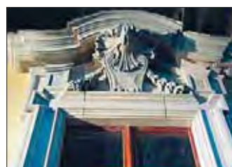
Schlüterfassade, Fensterbedachung, 1. Obergeschoss
