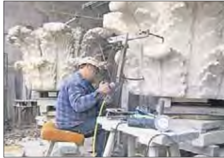
Sächsische Sandsteinwerke Pirna bei Dresden. Der Prototyp des Kolossalkapitells der Portale I und II wird nach dem Gipsmodell jetzt in Sandstein geschlagen.
