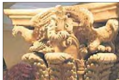
Kolossalkapitell Portal I und II, Aufnahme von 1950 (links) und fertiges 1:1-Modell als Vorlage für die Ausführung in Sandstein (rechts)
