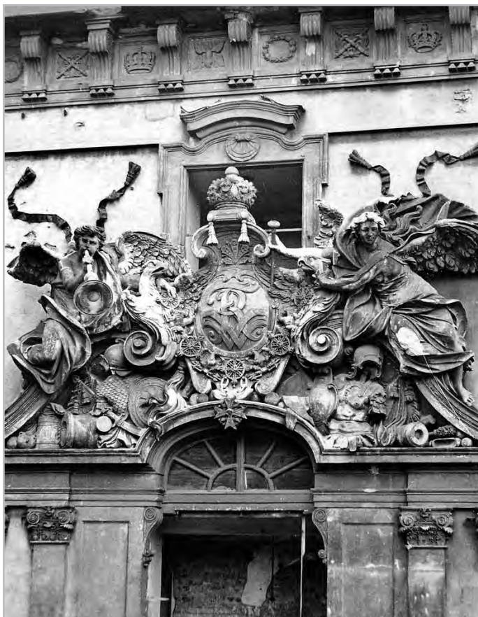
Supraporte Innenportal Großer Schlosshof. Hier haben wir inzwischen viele weitere Originalteile identifiziert, die für die geplante Rekonstruktion im Schlossforum verwendet werden können (Bild der Schlossruine 1950!).
