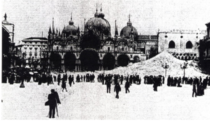
Der Trümmerhaufen des eingestürzten Campanile in Venedig 1902
