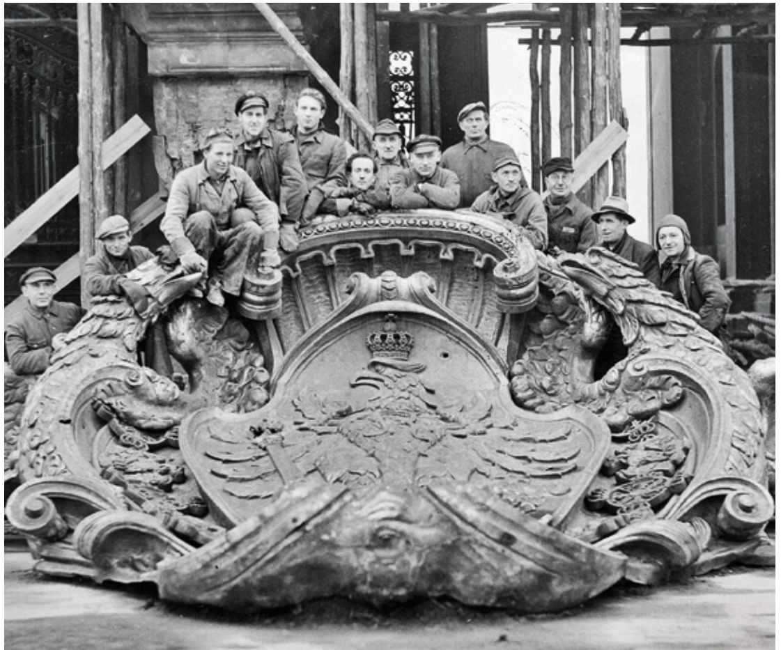
1950. Bauarbeiter mit der vor der Sprengung des Eosanderportals abgenommenen Kartusche. Mitten drin, ganz oben, mit verschränkten Armen und Schirmmütze Herbert Proksch. Weiter rechts davon, mit Nickelbrille, Paul Ernst
