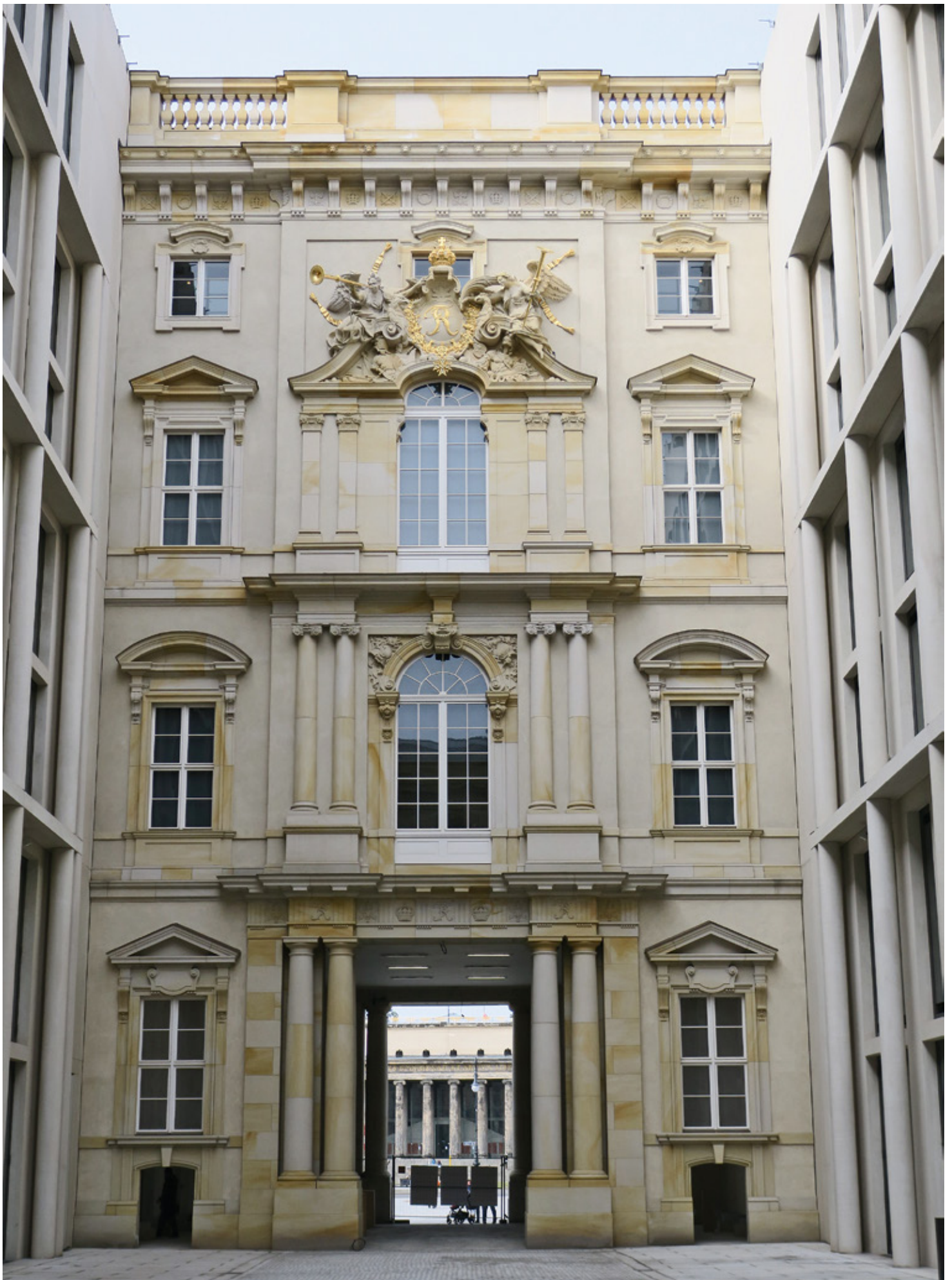
Die neue Nord-Süd-Passage durch das Schloss, Durchblick auf das Alte Museum. Das Forum wird sicherlich zu einem der beliebtesten Stadträume Berlins.
