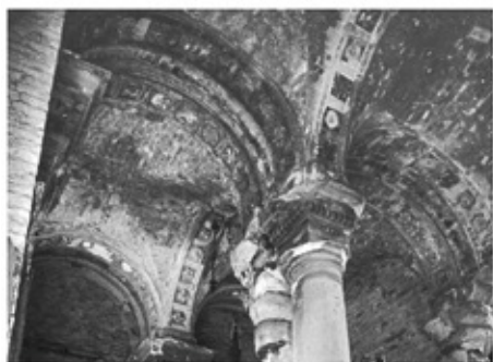
Gewölbe Westwand, hofseitig, 1950
