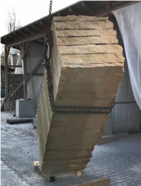
Der tonnenschwere Sandsteinblock wird aufgestellt.
