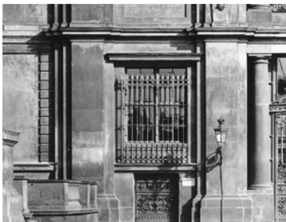
Originale Stahlschlupftür des alten Schlosses mit schmiedeeisernem Besatz, wilhelminische Zeit um 1900, am Portal IV links unten, mit drei verschließbaren Schießscharten
