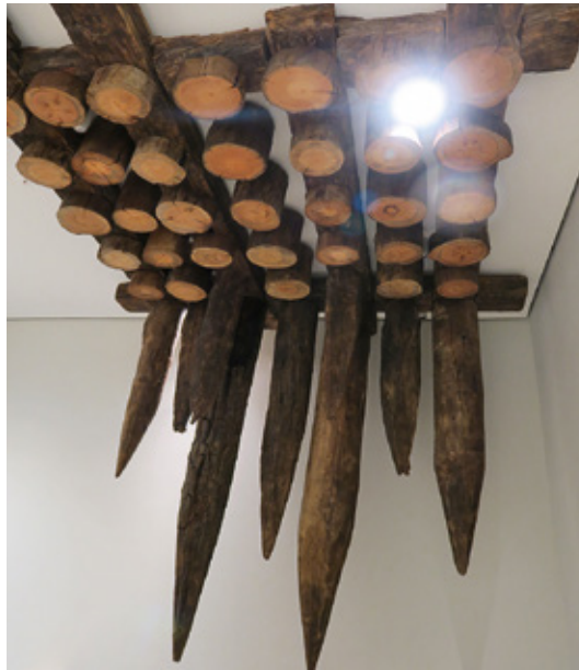
Wegen des sumpfigen Baugrunds stand das Schloss auf einer Pfahlroste. Diese sieht man nun von unten am Eingang zu den Schlosskellern.
