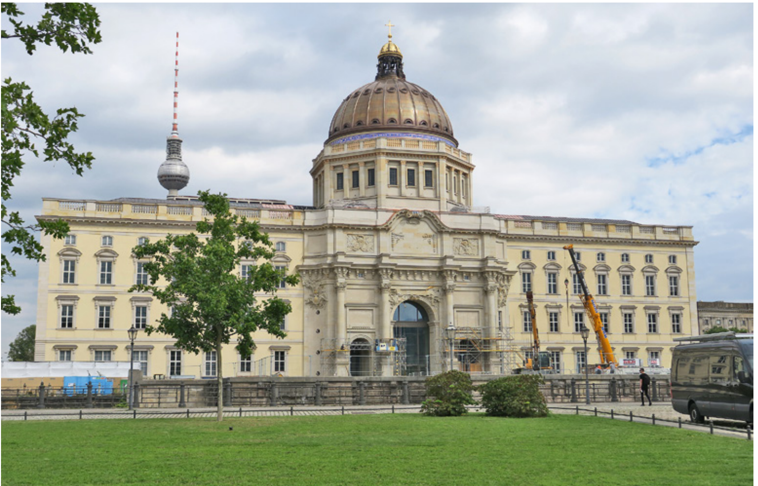
2020, Anfang September. Nun endlich wurde mit dem Abbau des Gerüsts am Eosanderportal begonnen.
