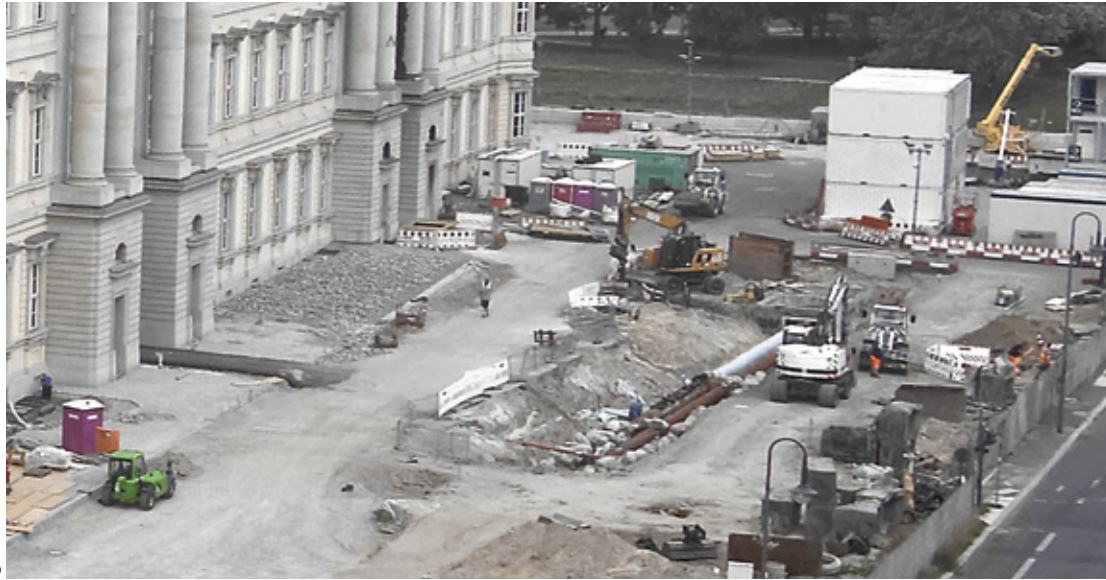
So sah die alte Fernwärmeleitung nach ihrer Freilegung aus.
