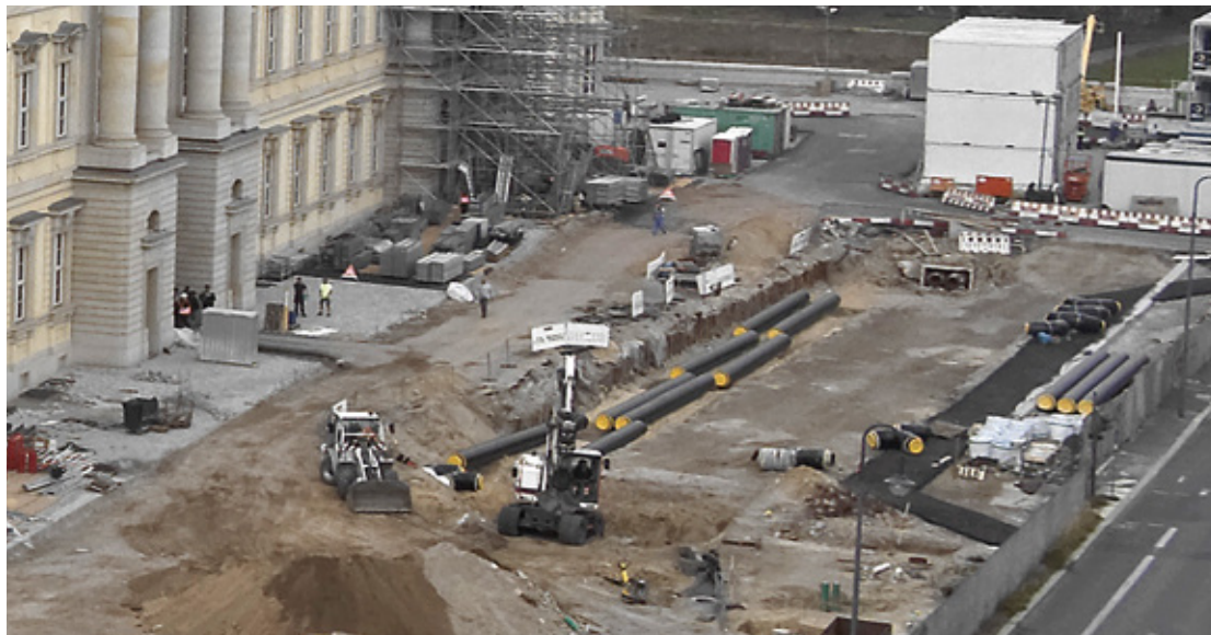
Deutlich erkennt man den Unterschied: Die neue Leitung wird wenige Meter näher an das Schloss verlegt, sodass sie in Zukunft nicht mehr unter dem Brunnen liegt.
