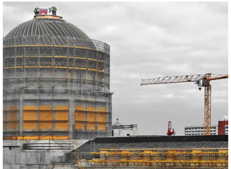
Die hölzerne Dachkonstruktion ist fertig. Ganz oben auf der Kuppel feiern die Zimmerleute ihren Erfolg.
