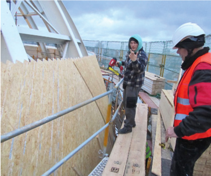
Die Beplankung der unten elliptischen und oben kreisrunden Kuppel wurde zu einer mathematischen Meisterleistung.
