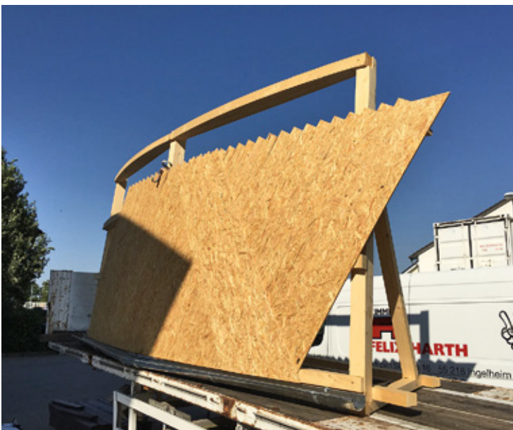
Probeanfertigung der Beplankung auf dem Hof der Harthschen Zimmerei
