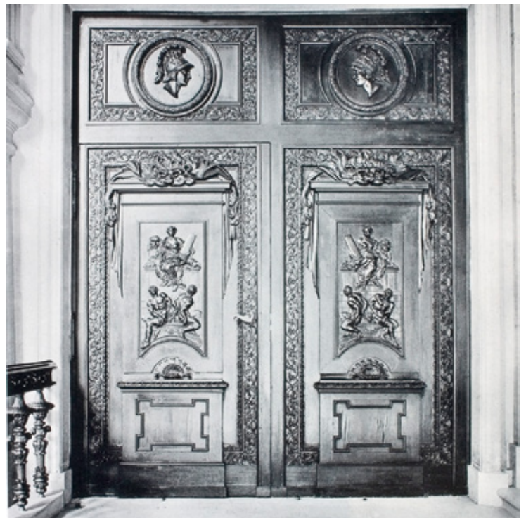
Die reich gestalteten Eichenholztüren der Treppe können ebenfalls rekonstruiert werden. Ein Original dieser Doppelflügeltür befindet sich im Depot des Stadtmuseums Berlin.
