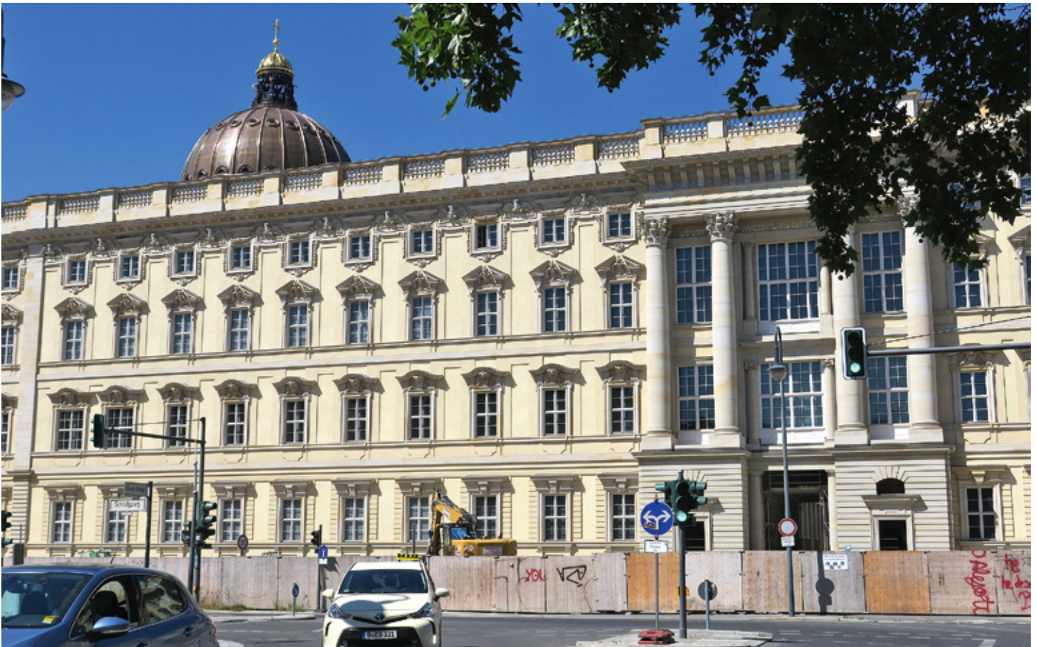
2020, Ende August. Das Schloss von Süden, noch abgesperrt mit dem Bauzaun.
