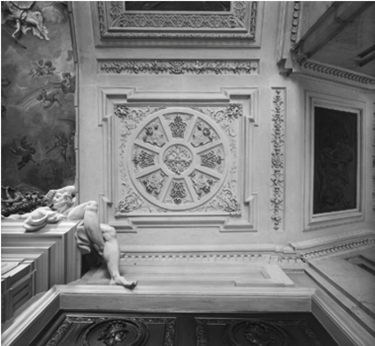
Kostbare Stuckdecken schmückten die Unterseiten der Treppenläufe. Eine, vor der Sprengung ausgebaut, befindet sich im Schloss Köpenick und ist ein wunderbares Muster, aus dem auch die anderen Decken abgeleitet werden können, deren Gestaltung hervorragend fotografisch gesichert sind.
