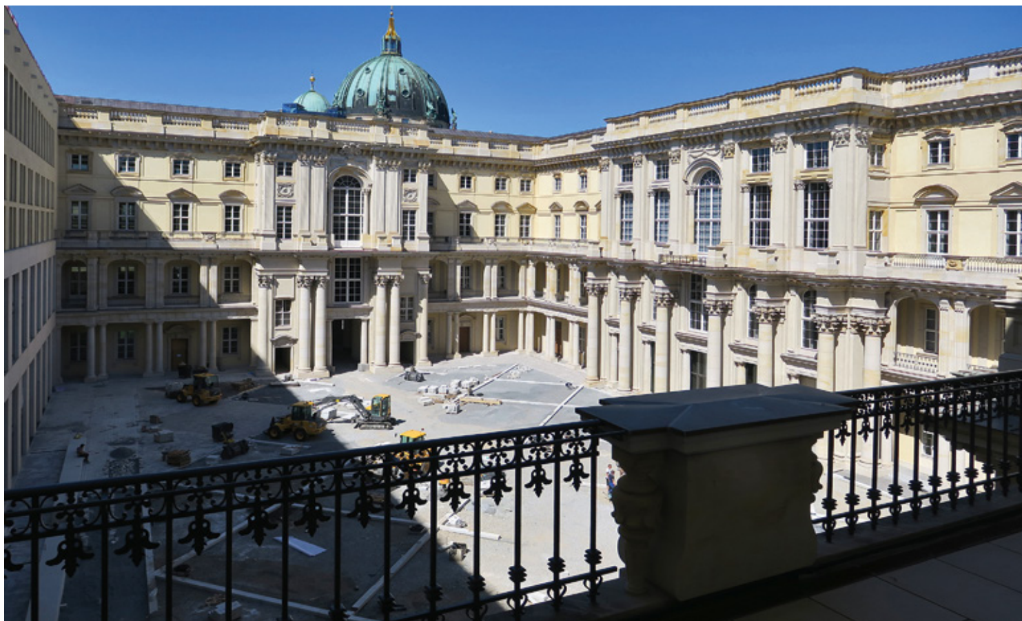
2020, Ende August. Der Schlüterhof von Südwesten. Der Boden wird noch gepflastert, die Skulpturen kommen wohl erst im Oktober auf ihre Sockel über den Kolossalsäulen.
