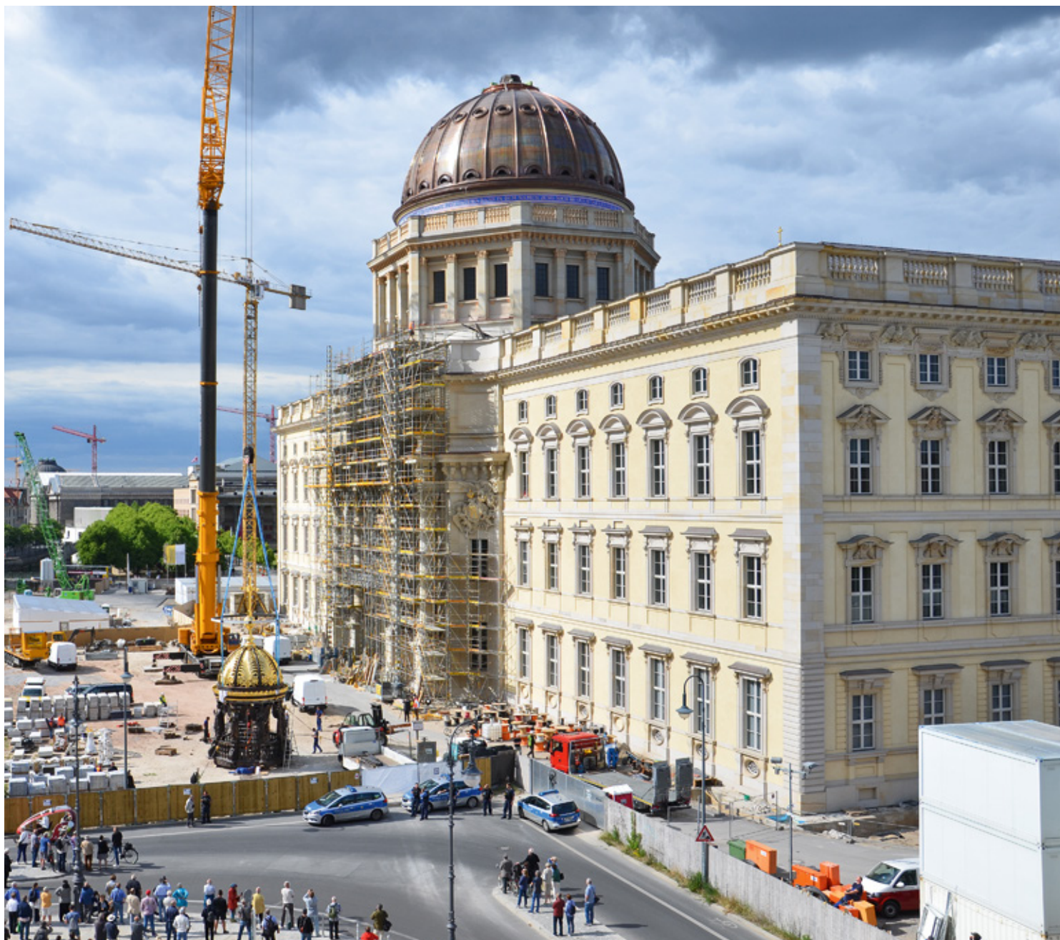
Die fertig zusammengebaute Laterne vor ihrem Aufzug auf die Kuppel
