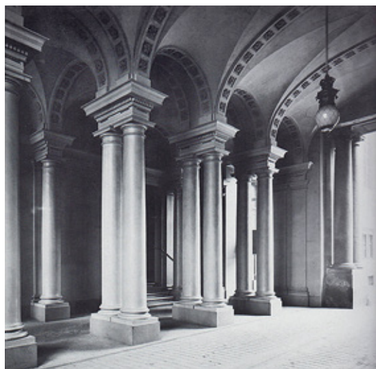
Vestibül des Portals IV vor dem Krieg, z. Z. nur Hohlkörper im Rohbau
