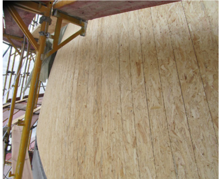
Die Beplankung der unten elliptischen und oben kreisrunden Kuppel wurde zu einer mathematischen Meisterleistung.
