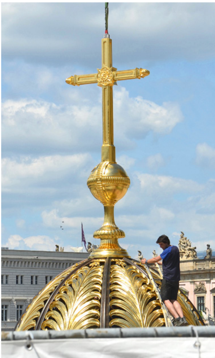
Schlussarbeiten an der Befestigung des Kreuzes
