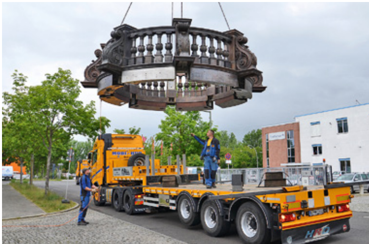
Die Balustrade der Laterne. Die acht Cherubim wurden erst vor dem Schloss montiert. Beim Transport von Weißensee aus wäre das Unterteil der Laterne sonst an jeder Brücke hängen geblieben.
