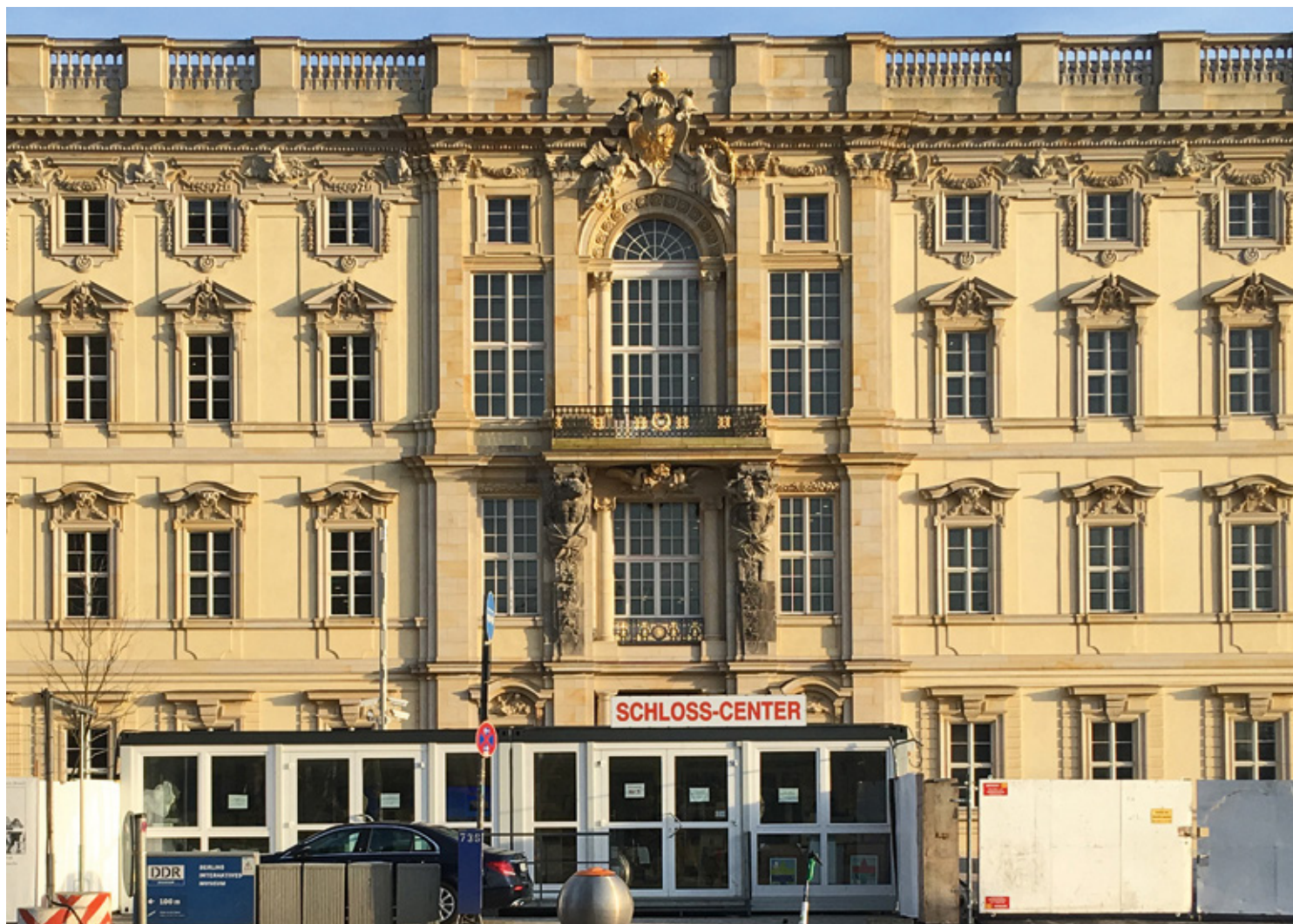
Das neue Schloss-Center in einer Containeranlage am Lustgarten
