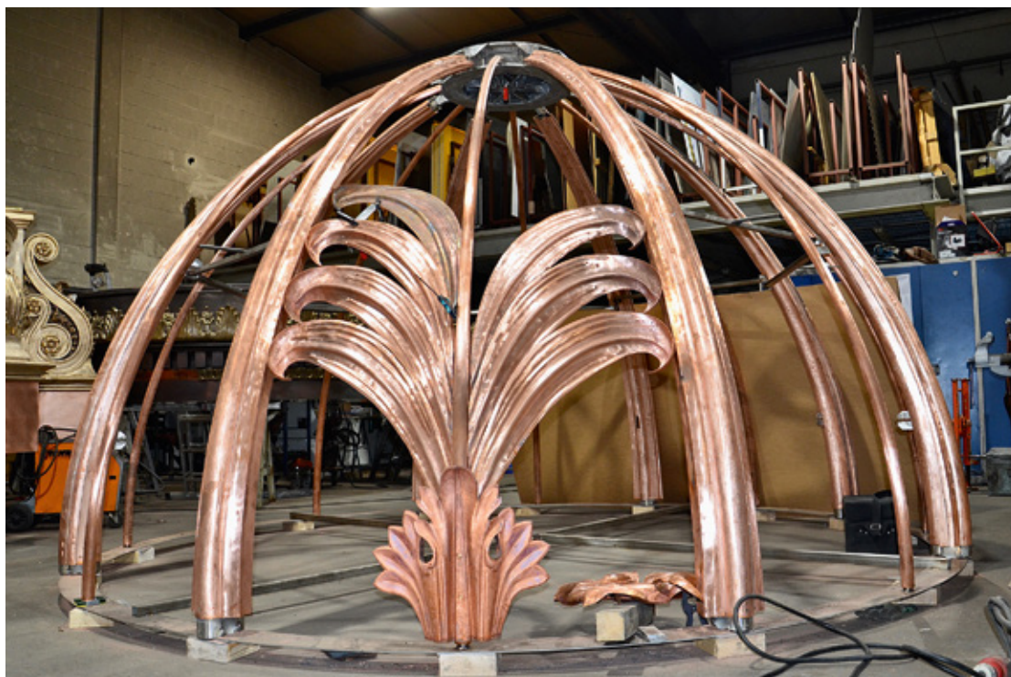
Kuppel der Laterne in Bau mit Palmetten
