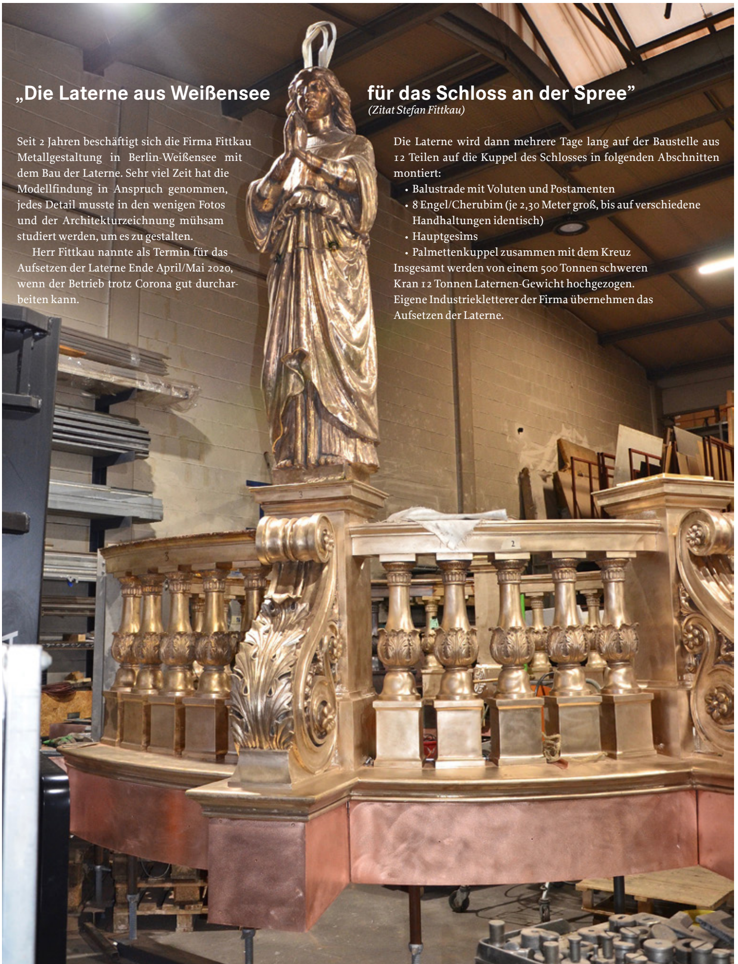
Bau der Laterne auf der Kuppel. Unterbau mit einem mit einem Cherub, noch ohne Flügel. Unglaublich ist die Detailtreue, die man später nur mit einem guten Fernglas von unten erkennen kann! Vom verlorenen Original existieren als Vorlage die Pläne aus der Mitte des 19. Jahrhunderts.
