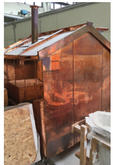
Kupfernes Häuschen, Musterstück für die Kupferverarbeitung am Dach, Gartenhäuschen für Kinder?
