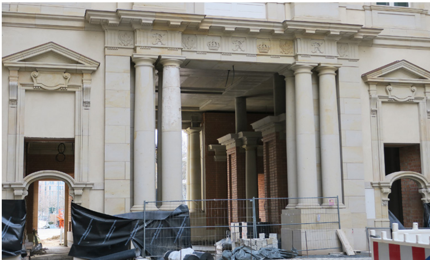
Das Berliner Schloss 2020, das neue Stella-Forum, Südportal II, Portaldurchgang. Bei der zweiten Säule von links wurde in den Schaft die gesprengte vorherige Säulentrommel oben eingebaut. Sie wurde von den Archäologen in dem darunter liegenden, mit Schutt gefüllten Keller gefunden.
