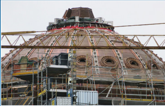
Das Kupferdach der Kuppel ist fast fertig. Oben sieht man die Aufnahmevorrichtung für die Laterne.
