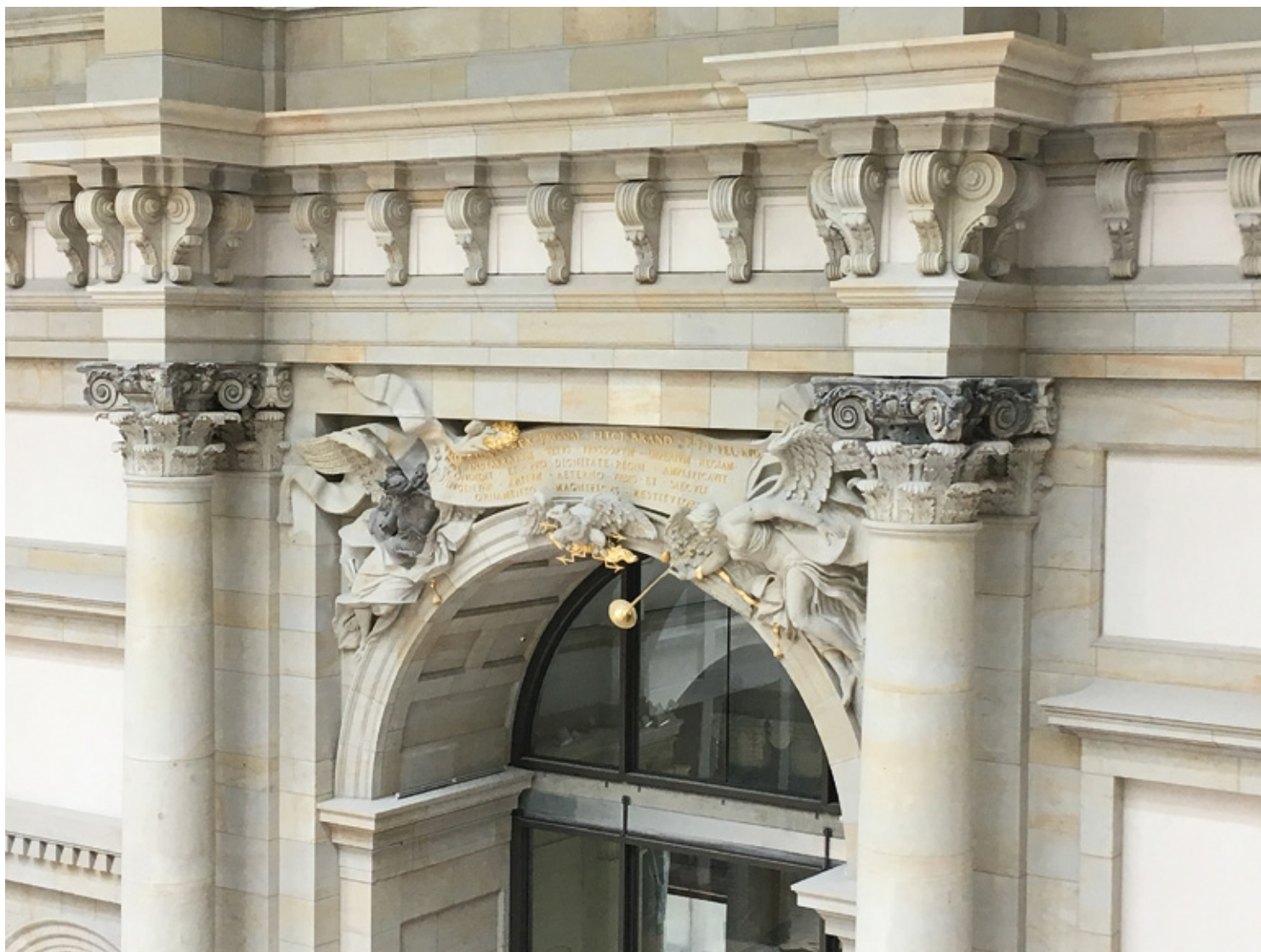
Das Berliner Schloss 2020, das neue Schlossfoyer, Innenportal III, mit drei historischen Spolien des alten Schlosses
