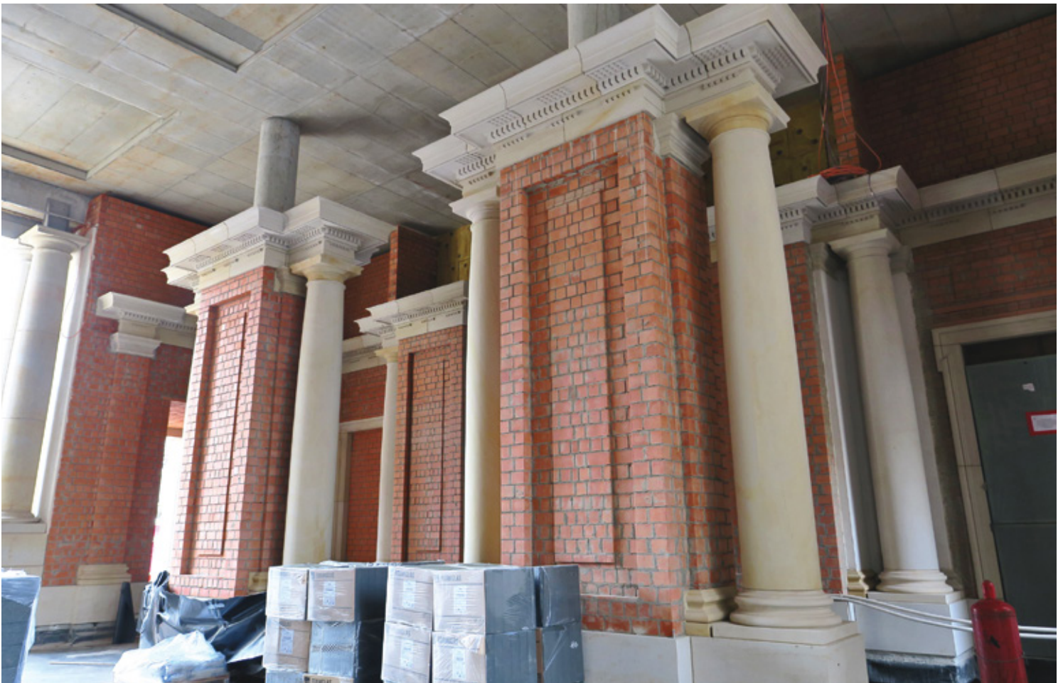
Das Berliner Schloss 2020, Schlossplatzfassade, Vestibül von Portal II im Bau
