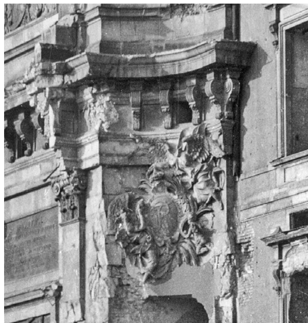
Die durch Beschuss 1945 schwer beschädigte Kartusche im September 1950
