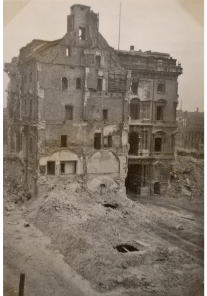
Reste des Quergebäudes von Lynar, daneben die Reste von Innenportal II. Die hellen Flecken oben markieren den Ausbau der Genien. Vorn eine bereits durchschlagene Kellerdecke.
