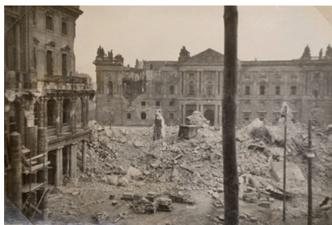
Blick vom Nordportal V über das gesprengte Schlossplatzportal I auf den Marsstall, der damals noch seinen charakteristischen Giebel hatte.
