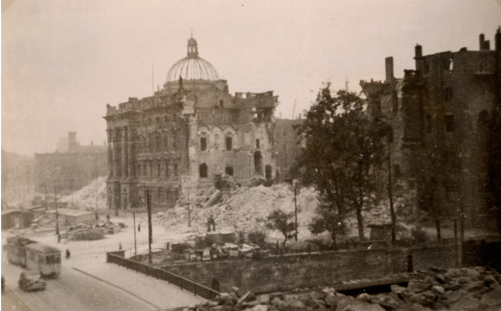
... seine linke Säule mit einem Stück der Fassade blieb stehen ...
