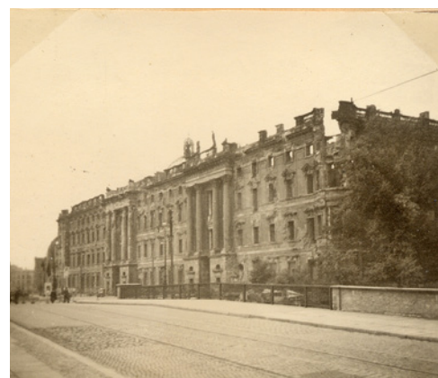
Die Südfassade zum Schlossplatz
