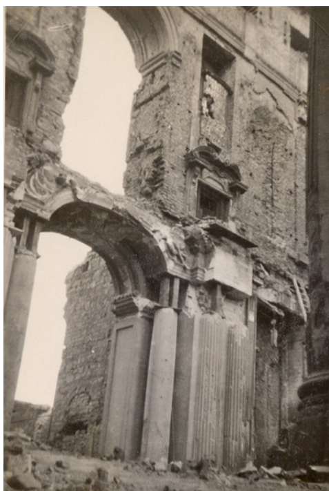
Die Rückwand der Gigantentreppe im ersten Stockwerk, darüber der Schweizer Saal mit Kaminen
