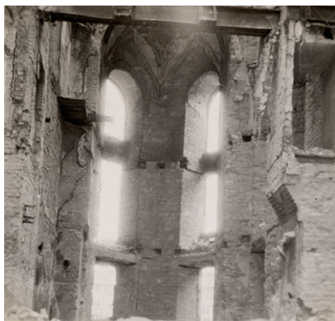
Die Erasmuskapelle. Die später eingebauten Zwischenböden sind eingestürzt, so zeigt sie ihre ursprüngliche Gestalt.
