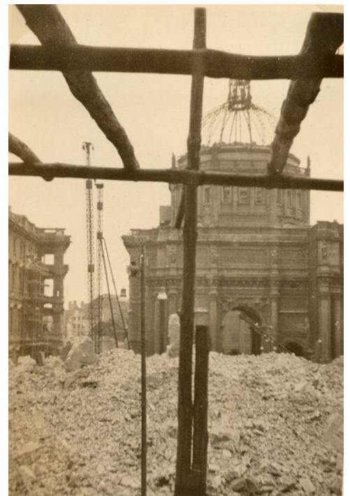
Der Schutthaufen des gesprengten Quergebäudes
