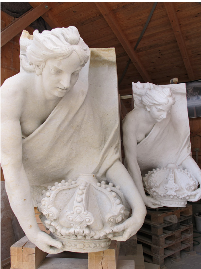
Genius der Nordkartusche, links der fertig bearbeitete Sandstein, rechts das Gipsmodell
