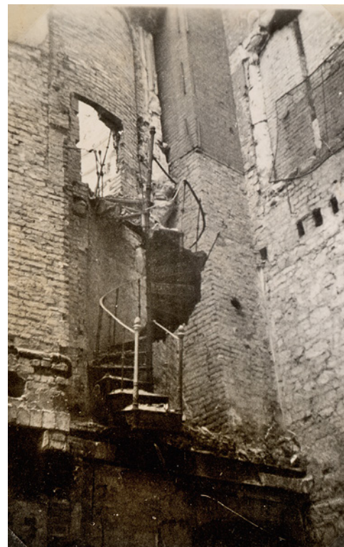
Die Wendeltreppe am Grünen Hut
