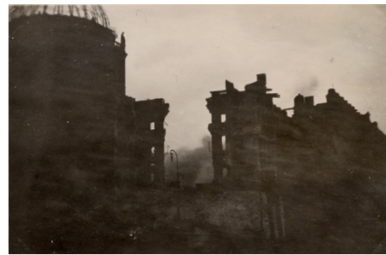
Die Sprengung des Quergebäudes, hier Nonnenbau genannt
