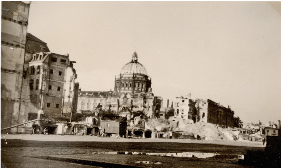
Die Schuttberge der gesprengten Südwestecke des Schlosses, fast 1/3 so hoch wie das Schloss selbst, zeigen wie massiv das Mauerwerk war.
