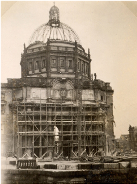
Abbau des Gerüsts von Portal III
