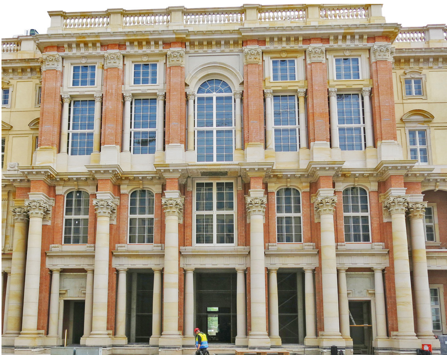
Portal VI im Schlüterhof, Bauzustand 2018. Die dunkle Stelle unter dem Balkon über dem Mittelportal ist die historische Original Balkonplatte, s. Seite 105
