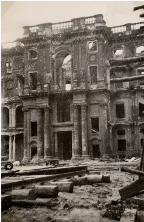
An der Spree wurden die Mauern weitgehend von Hand abgebrochen, da der Schutt nicht in die Spree rutschen sollte.
