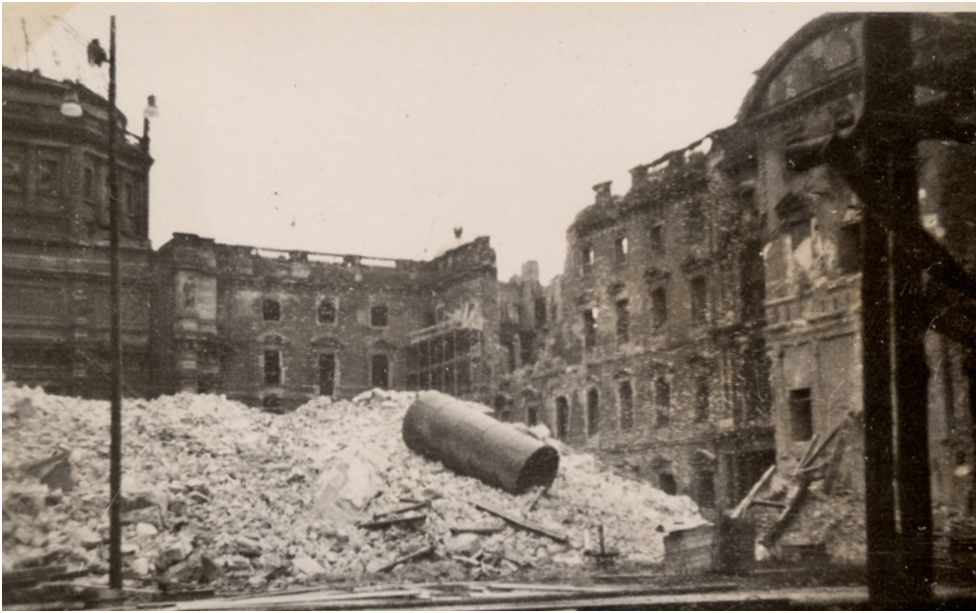
Blick aus dem Schlüterhof in den Großen Schlosshof, vorn der Schuttberg des Quergebäudes
