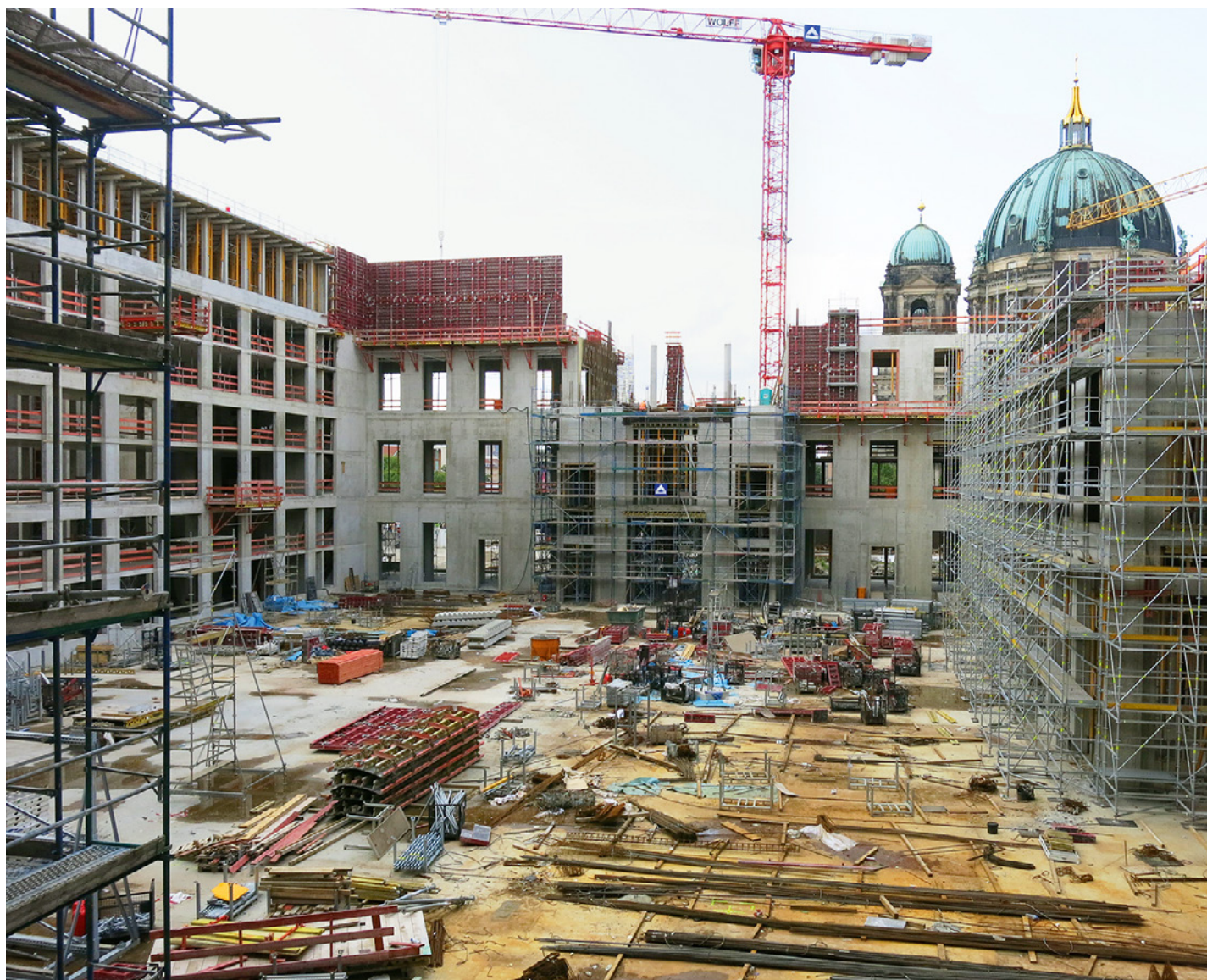
Der Rohbau im August 2014. Der Schlüterhof nach Norden.
