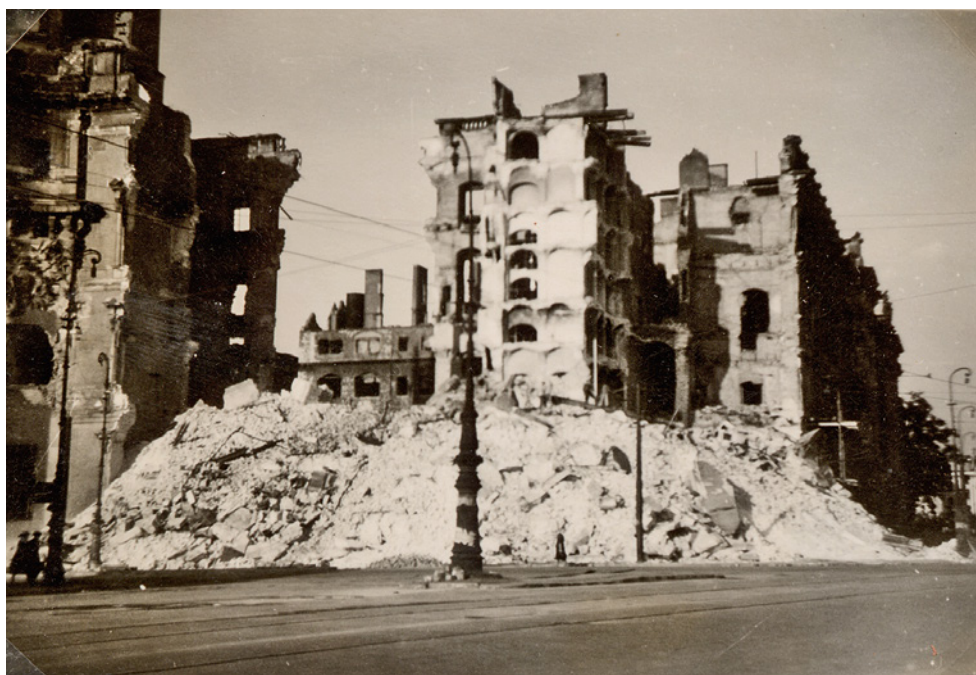
Das aufgerissene Treppenhaus der Hohenzollerntreppe
