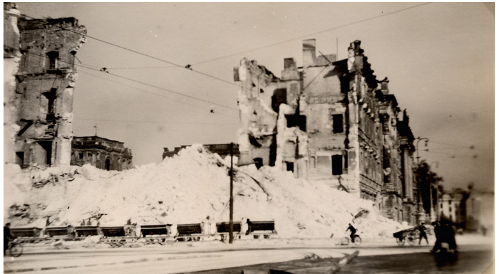
Die Hohenzollerntreppe ist gesprengt, im Vordergrund die Kipploren auf Schienen, gezogen von einer kleinen Dampflokomotive, die zum Abtransport der Trümmer dienten.
