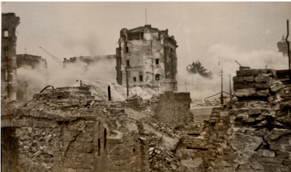
... und wird hier gesprengt. Übrig ist nun nur noch Portal II der südlichen Schlossfassade.
