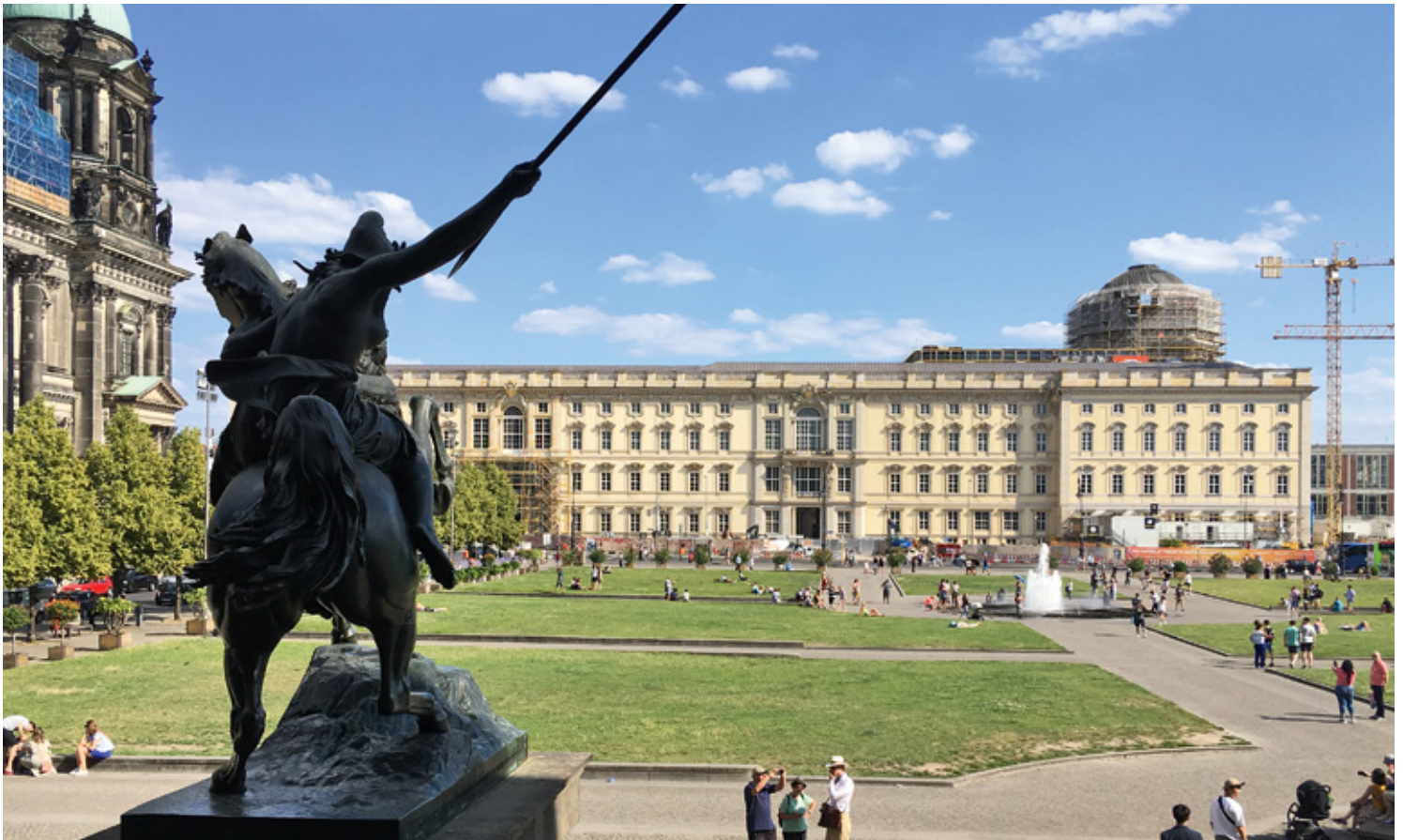
Nun endlich wurden im Mai 2019 die Arbeiten am Kupferdach der Kuppel begonnen. Mit der äußeren Fertigstellung des Schlosses rechnen wir im Herbst. Ein Höhepunkt wird dann der Tag sein, an dem die Laterne auf die Kuppel gesetzt wird.
