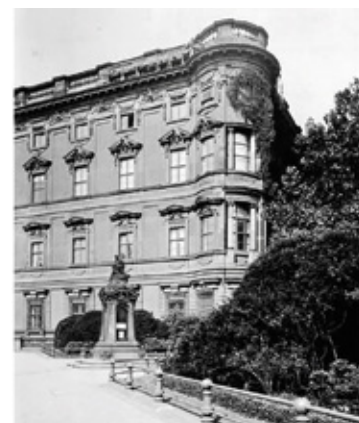
Südwestecke des Berliner Schlosses mit Wettersäule, Foto um 1910
