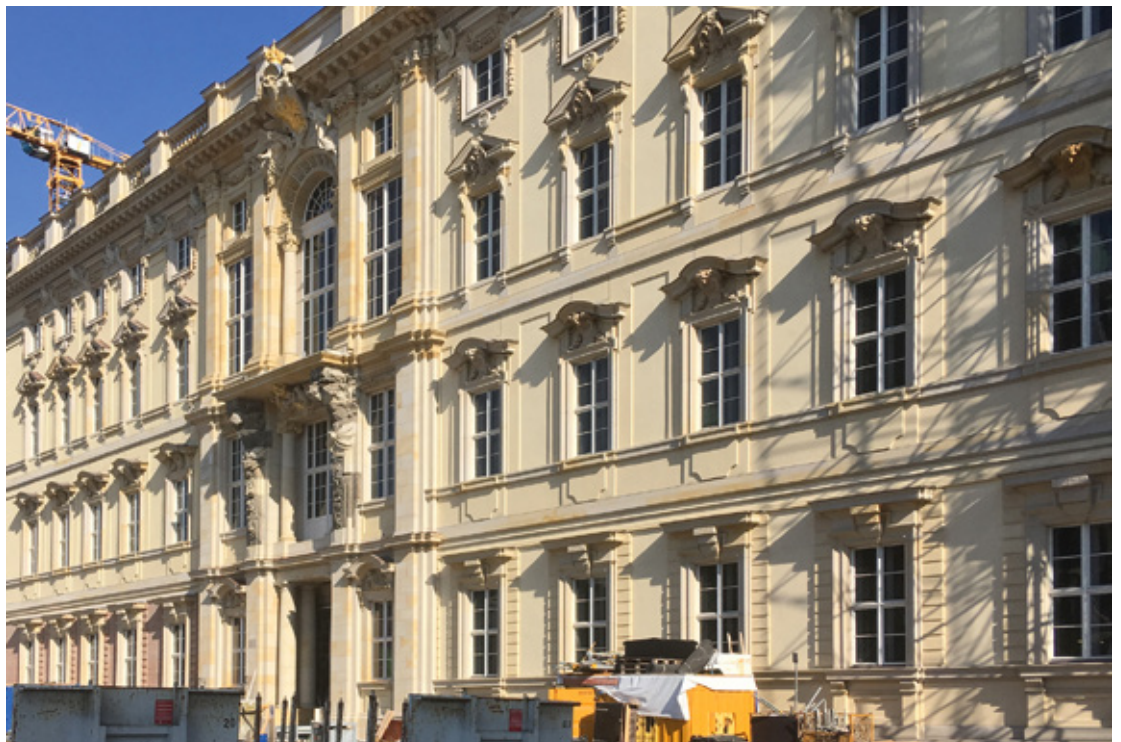
Die Schönheit der Schlossfassaden wird sichtbar. Sie wurden im Spätsommer 2018 weitestgehend fertiggestellt!
