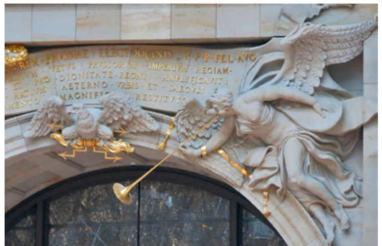
Eosanderportal (III) innen zum Großen Foyer: Die Vergoldungsarbeiten wurden beendet und die lateinische Inschrift angebracht.
