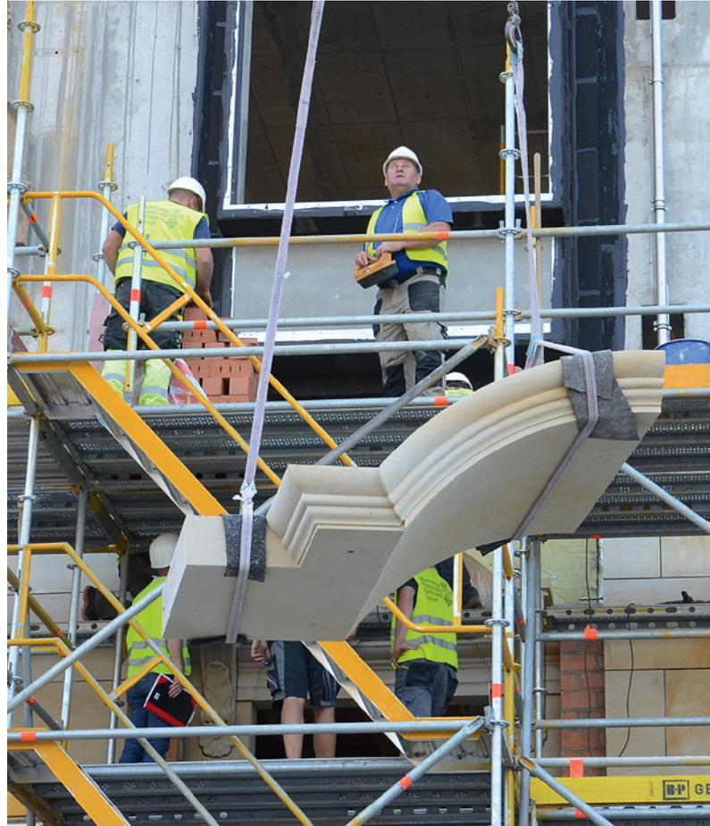
An der Fensterverdachung sieht man, wie tief alle Sandsteinelemente in das Ziegelmauerwerk eingelassen werden.
