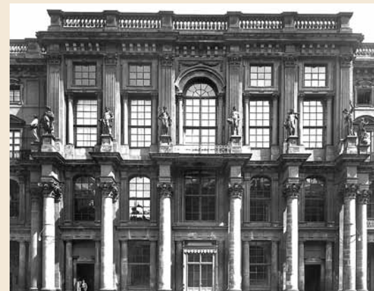
Treppenhausrisalit an der Ostwand des Hofes
